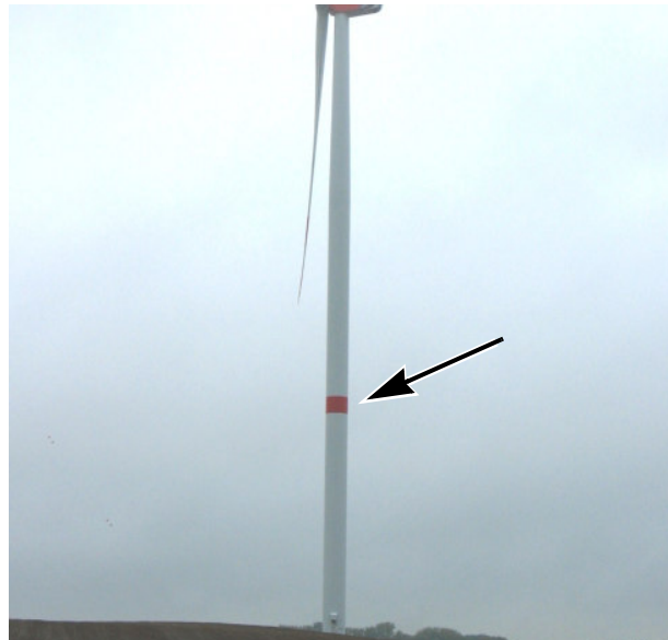
Abb. 4 Roter Farbring an Anlage mit Gesamthöhe >150 m
