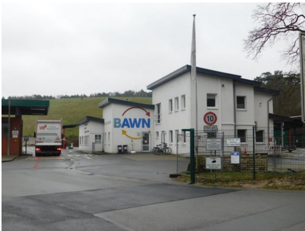
IP20 - An der Steingrube 1, 31582 Nienburg
