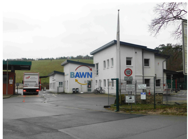
IP20 - An der Steingrube 1, 31582 Nienburg
