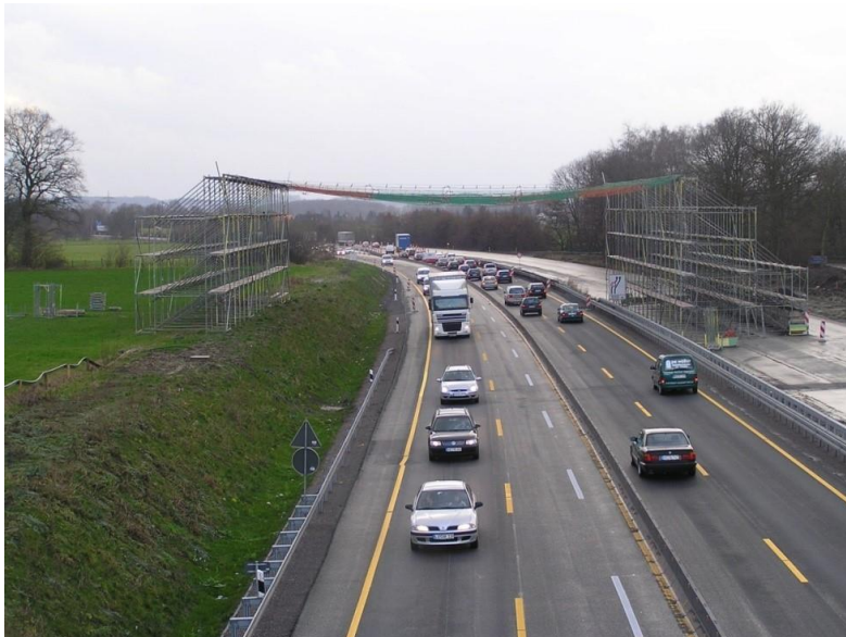
Abbildung 3-10: Stahlrohrkonstruktion mit Netz zum Schutz über einer Autobahn (Quelle: Amprion)
