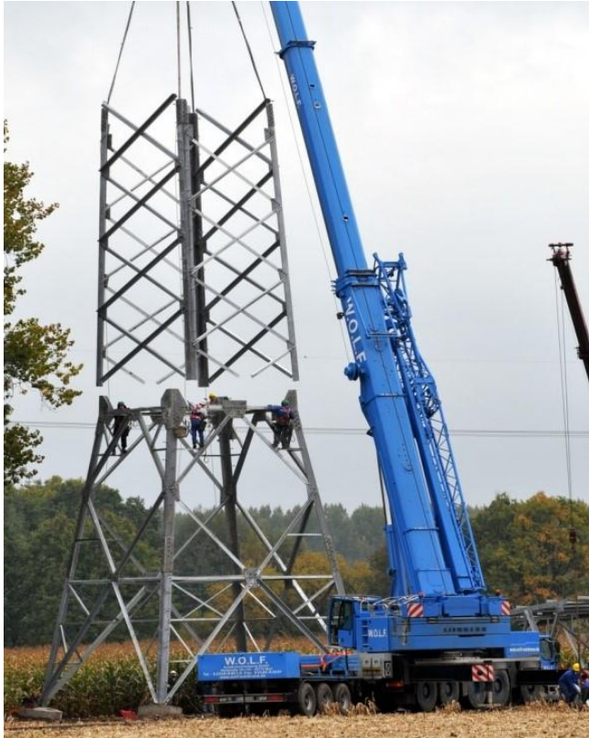
Abbildung 3-8: Mastmontage, Stocken (Quelle: Amprion)
