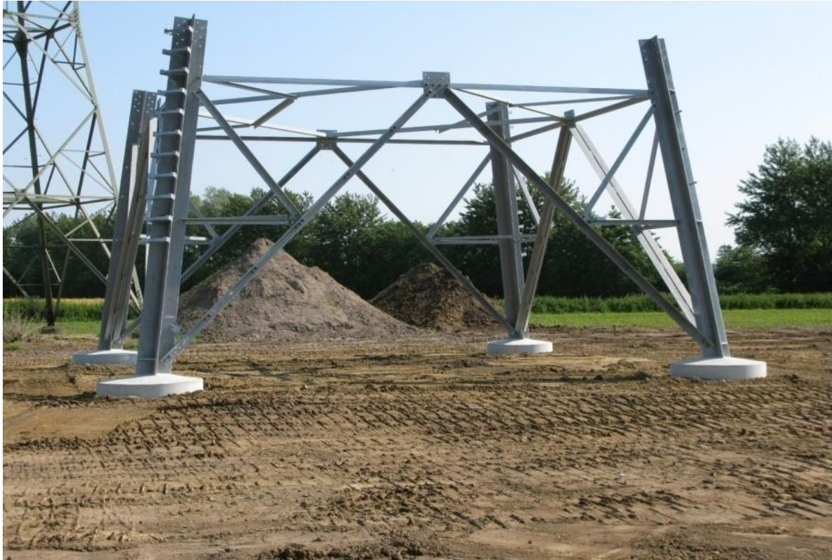
Abbildung 3-7: Montierter Mastfuß (Quelle: Amprion)
