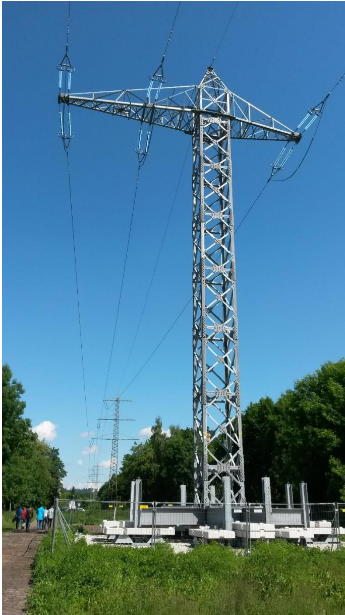
Abbildung 3-14: Darstellung Freileitungsprovisorium (Quelle: Amprion)
