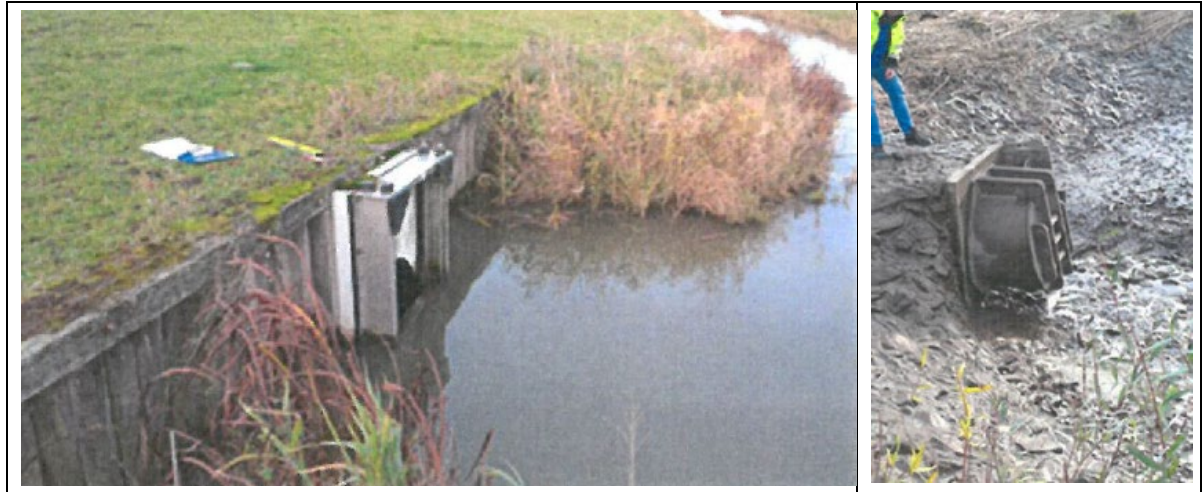
Abbildung 6: Bilder Durchlassbauwerk Hunteseite 2018
