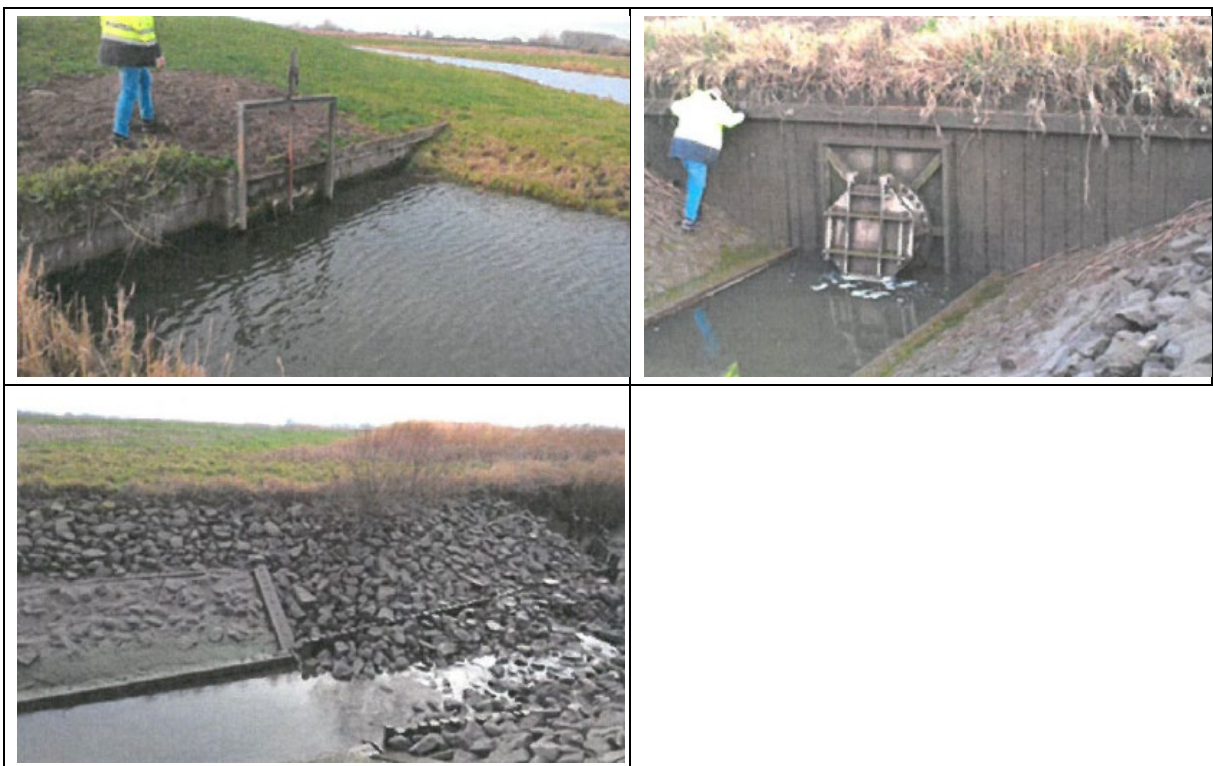
Abbildung 10: Bilder Durchlass Weserseite 2018
