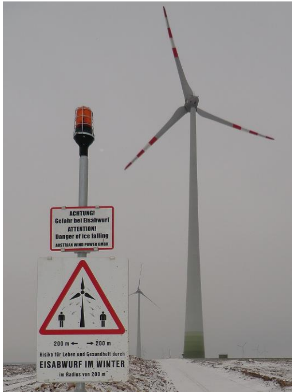
Abb. 1: Möglicher Aufbau einer Eiswarnleuchte mit zusätzlichen Warnschildern
