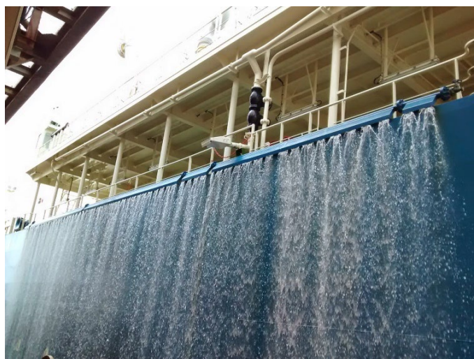
Abbildung 5: Wasservorhang zum Schutz der Schiffswand vor Kontakt mit LNG
