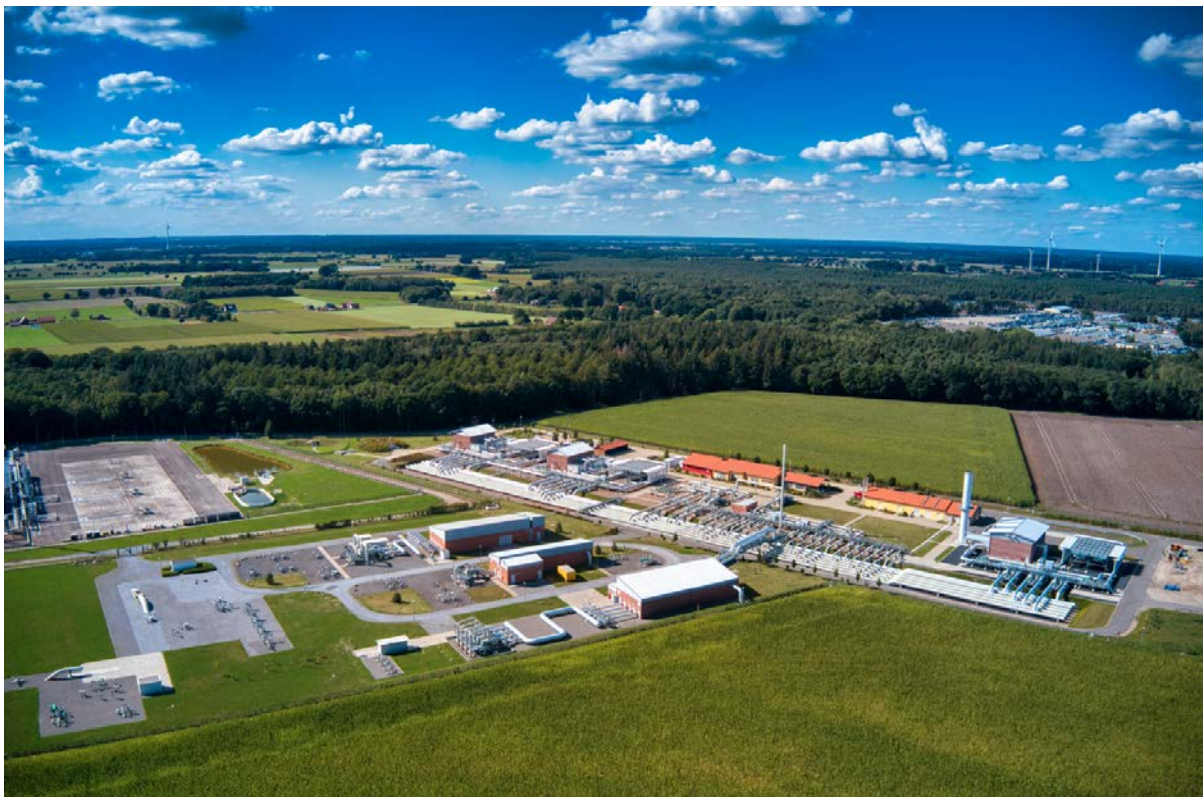
Abbildung 14: VS Rehden, GDRM Anlage, Erweiterungsfläche (GASCADE)
