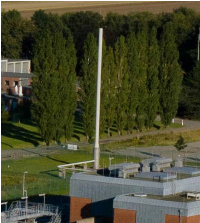
Abbildung 11: Ausschnitt aus dem Freiflächenplan – Ausbläser und Beispiel eines Ausbläserturms
