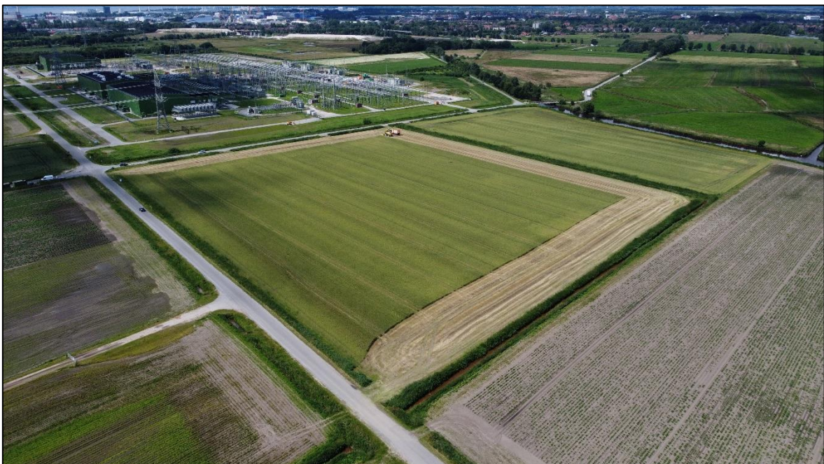
Abb. 3: Blick Richtung Westen auf Baufläche B (Biotoptyp AT) mit nördlich verlaufendem Fehntjer Tief (FVM) und südwestlich gelegenem Umspannwerk Emden-Ost (Biotoptyp OKV) (H & M 19.06.2024) 1
