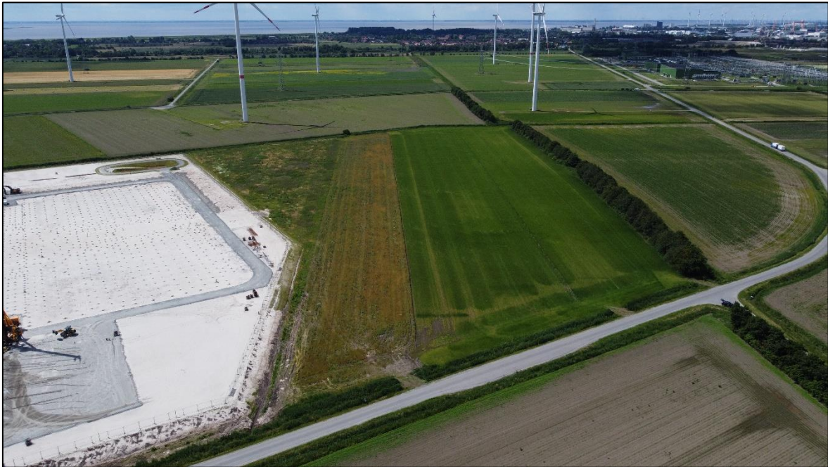
Abb. 2: Blick Richtung Süden auf Baufläche A (Biotoptyp AT) und südlich gelegener Baufläche C mit westlich (rechts) verlaufendem Gehölzstreifen (HPS) und östlich (links) gelegener Baustelle des HGÜ-Konverters (H & M 19.06.2024)
