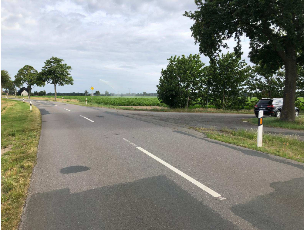
Bild 1: Vorhandener Einmündungsbereich K25 Blick in Richtung Norden, km 0+000 (Aufnahme am 07.07.2020)
