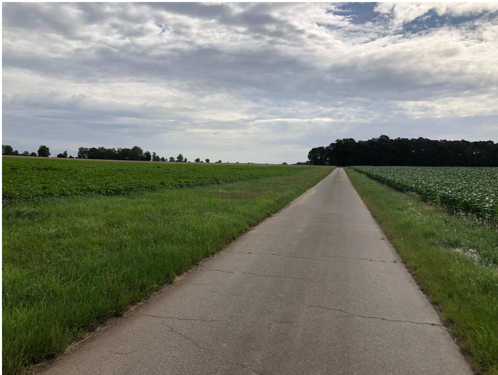
Bild 3: Wisswedeler Straße in Richtung Osten, Bau-km 0+070 (Aufnahme am 07.07.2020)
