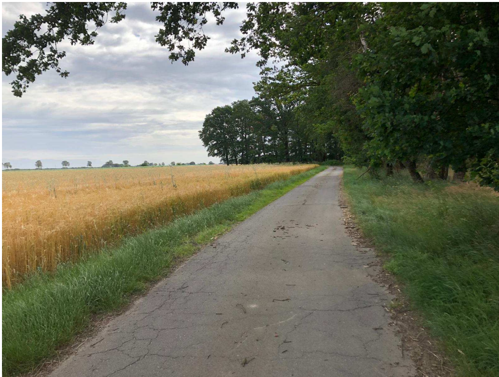
Bild 5: Vorhandene Fahrbahn Höhe An der Wieke in Richtung Osten (Aufnahme am 07.07.2020)
