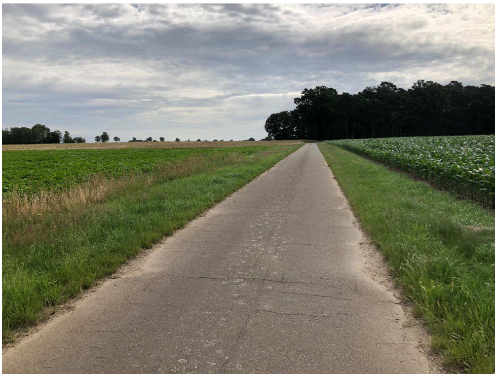
Bild 4: Wisswedeler Straße in Richtung Osten, Bau-km 0+250 (Aufnahme am 07.07.2020)
