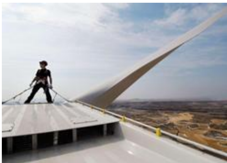
Abbildung 9-1: Arbeiten auf dem Maschinenhaus.
