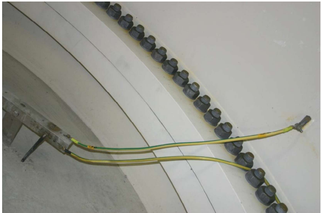
Abbildung 2-8: Verbindung zwischen Turm und Haupterdungsschiene
