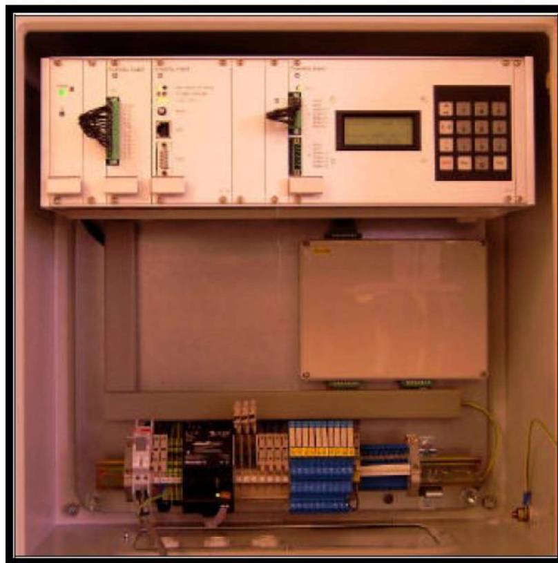
Abbildung 10-2: Schattenwurfmodul Innenansicht
