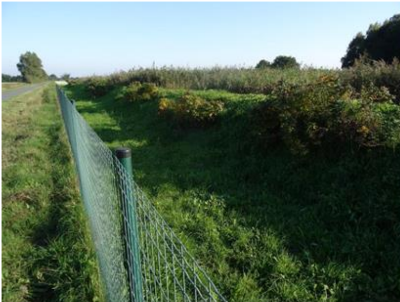
Abb. 5: Rohrweihen-Brutplatz im Absetzbecken der Uetzer Kläranlage
