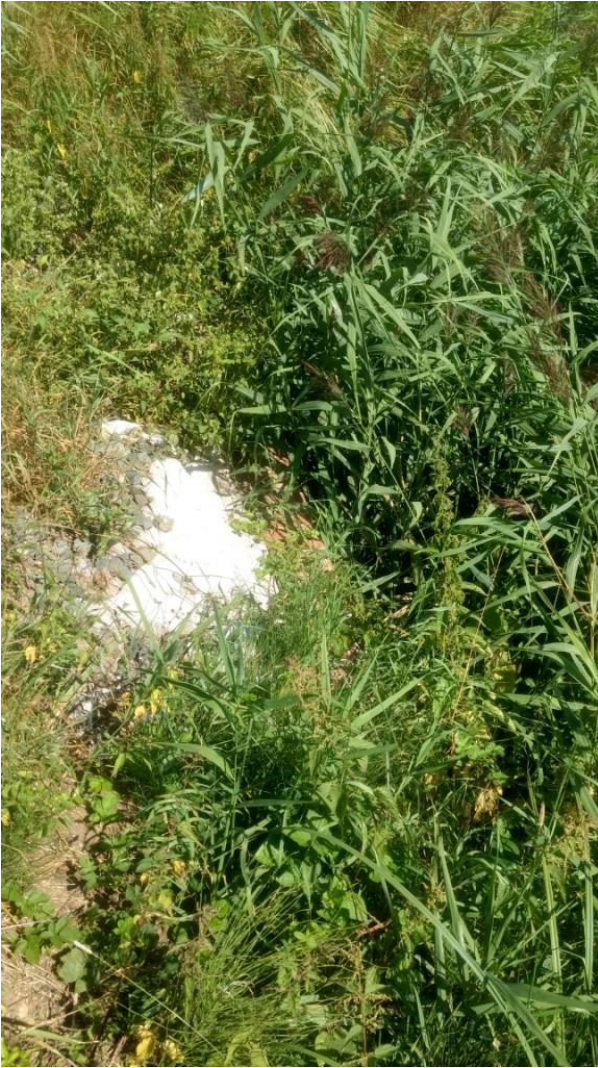
Foto 9: Temporäre Sicherung des defekten Durchlasses mit Vlies und Holzbohlen. Südliches Ende des Durchlasses mit Kopfbauwerk, Blick nach Südost.
