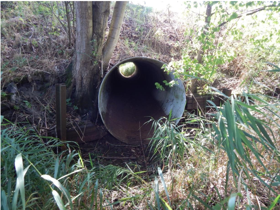
Foto 13: Wellblech-Durchlass östlicher Otter-Arm (trocken) von Norden gesehen am 29.08.2018 (Lemmel).
