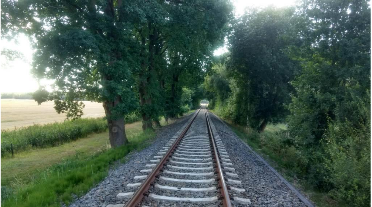
Foto 1: Blick auf die Gleisanlagen in Dammlage nahe der Otter, Blickrichtung Westen.
