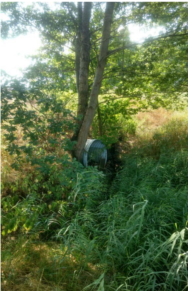
Foto 6: Hochwasserdurchlass (Armco) ca. 15 m östlich des Durchlasses der Otter. Blick nach Südost.
