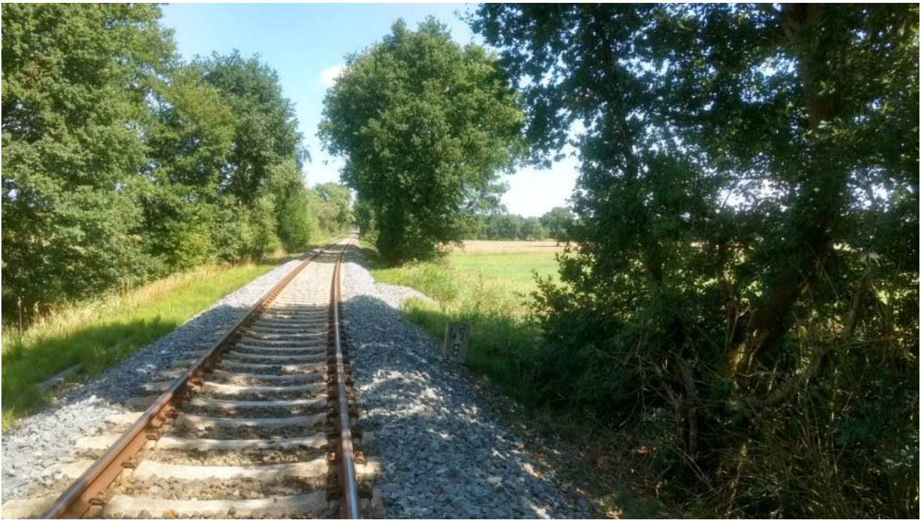
Foto 3: Gleisanlagen bei Bahn-km 45,800, auf Höhe des Durchlasses der Otter. Blick nach Osten.
