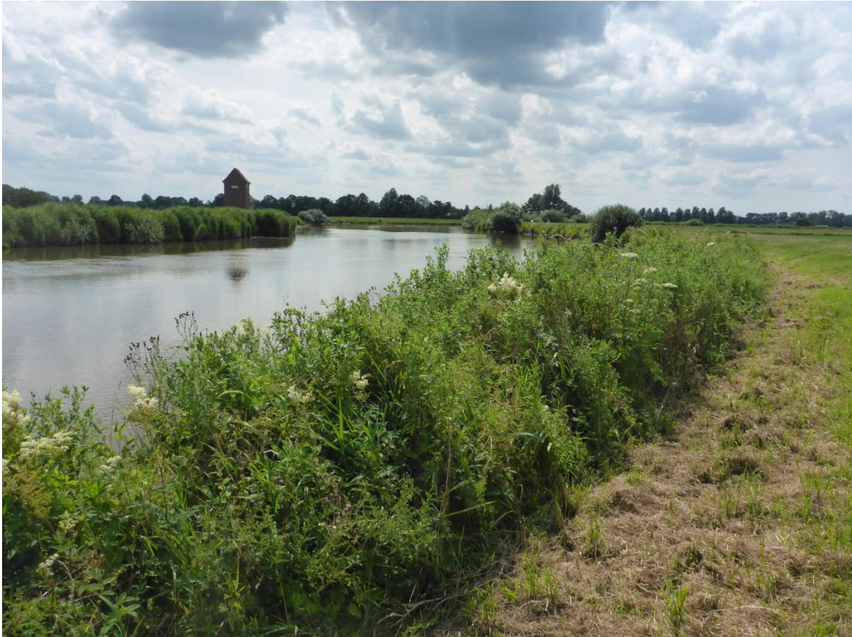
Abbildung 5.1-23: Schmalstreifiger Hochstaudenbestand unmittelbar vor dem Flußdeich (flächenhaftes Vorland fehlend)
