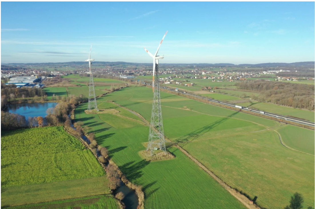
Abbildung 2 Bestehende WEA mit angrenzender Autobahn (Blickrichtung Nordwesten)
