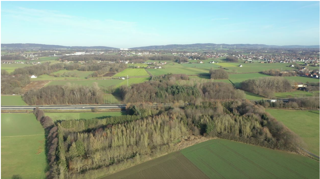
Abbildung 4 Gehölzfläche nordöstlich der bestehenden WEA
