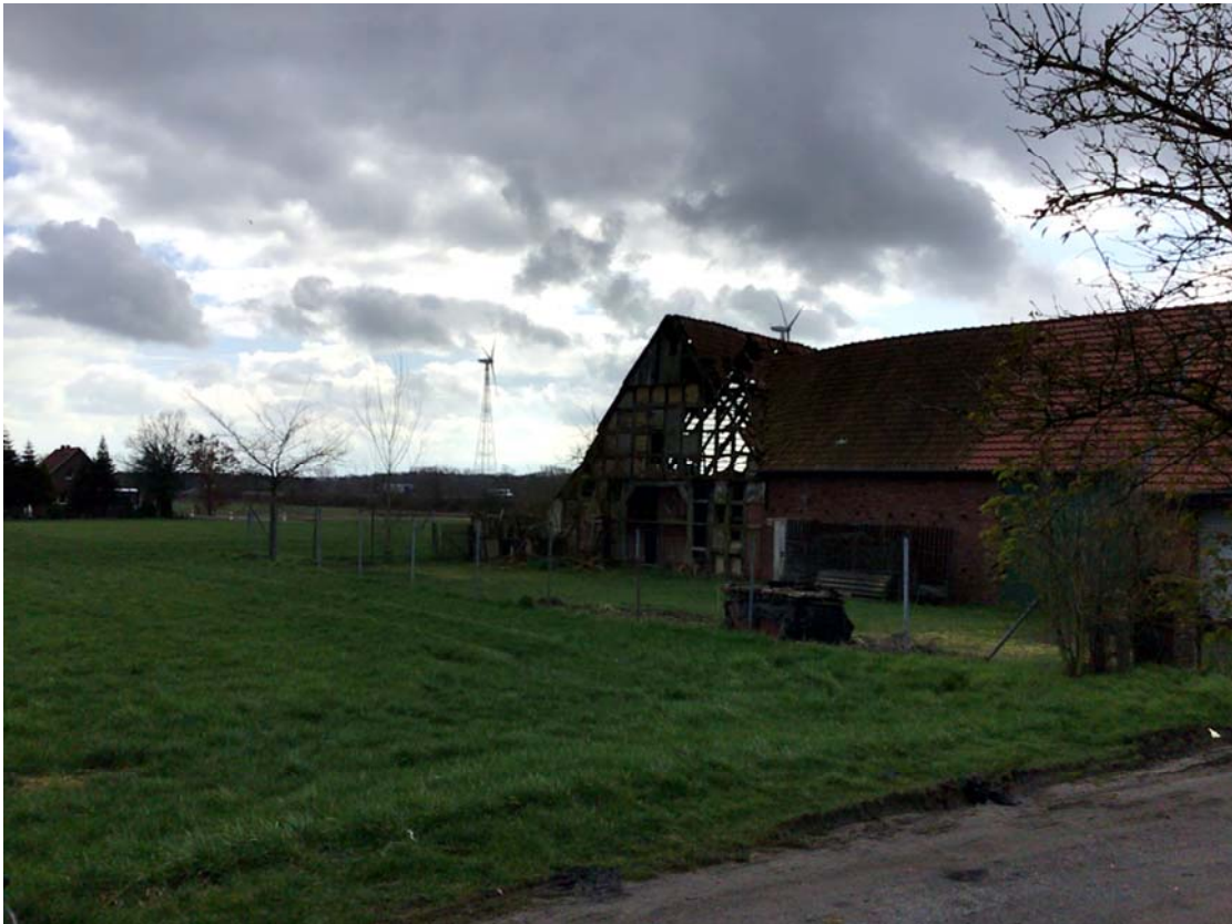
Bild 62: W16 - Darstellung der Sichtbeziehung mit bestehenden WEA
