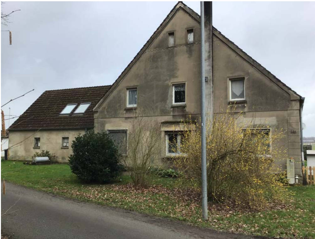
Foto 26: Blick auf die in Richtung Südwesten ausgerichtete Hausfront (östlicher Teil) des Wohnhauses W13
