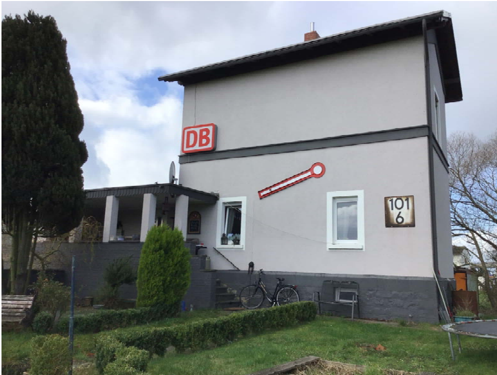
Foto 32: Blick auf die in Richtung Südosten ausgerichtete Hausfront des Wohnhauses W16
