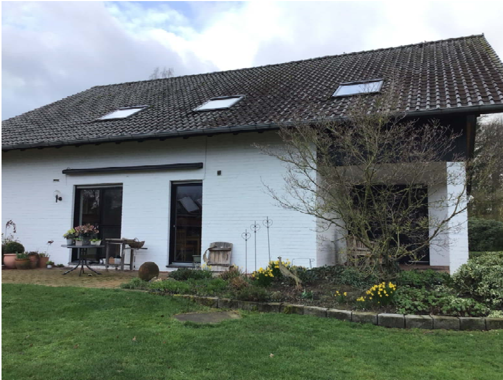
Foto 1: Blick auf die in Richtung Nordosten ausgerichtete Hausfront des Wohnhauses W01
