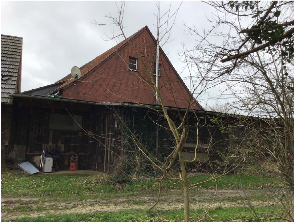
Foto 8: Blick auf die in Richtung Norden ausgerichtete Hausfront des Wohnhauses W04
