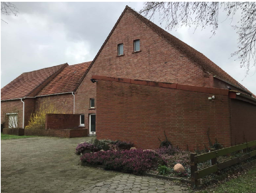
Foto 19: Blick auf die in Richtung Nordosten ausgerichtete Hausfront des Wohnhauses W09
