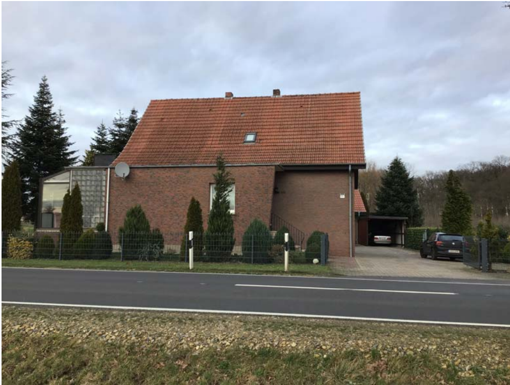
Foto 28: Blick auf die in Richtung Südwesten ausgerichtete Hausfront des Wohnhauses W14
