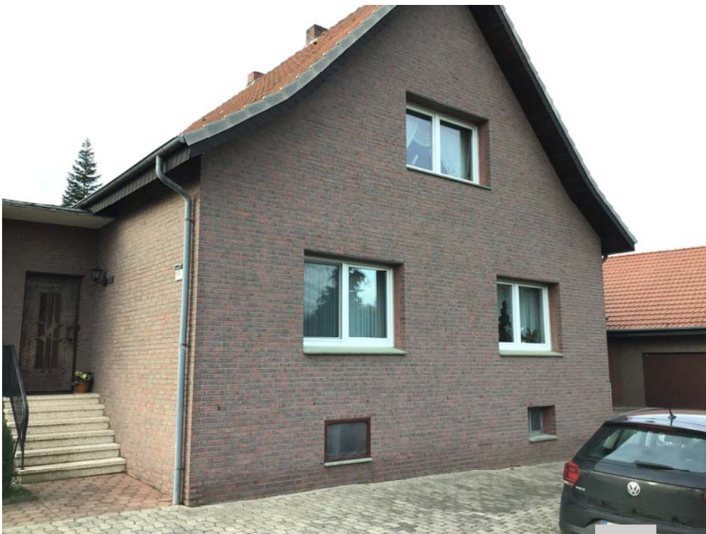
Foto 29: Blick auf die in Richtung Südosten ausgerichtete Hausfront des Wohnhauses W14
