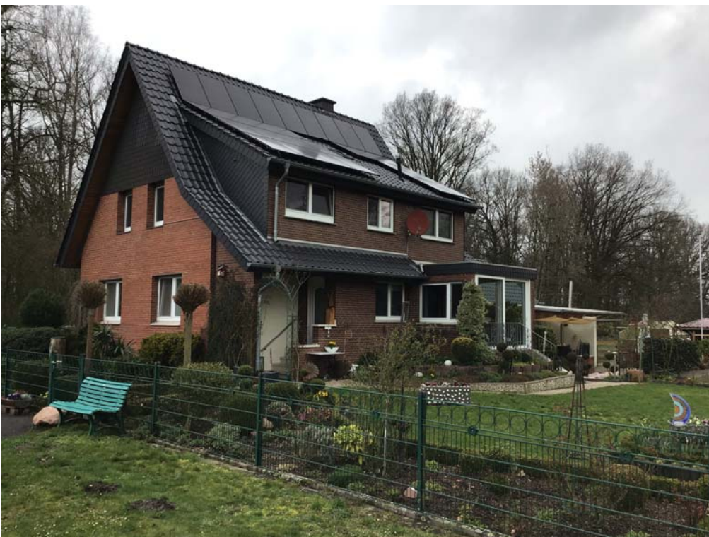
Foto 13: Blick auf die in Richtung Südwesten und Südosten ausgerichteten Hausfronten des Wohnhauses W06
