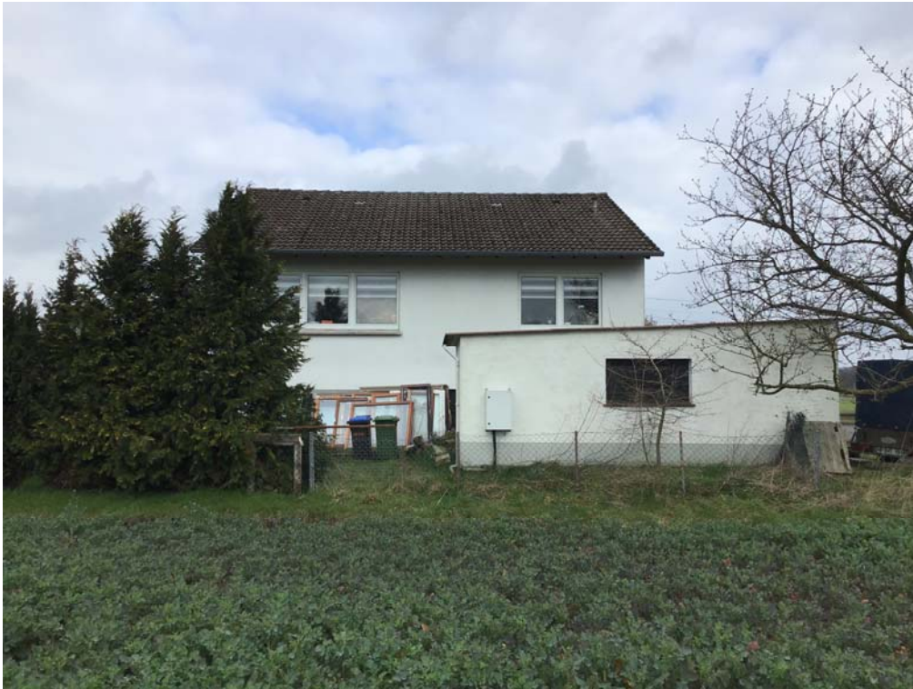
Foto 20: Blick auf die in Richtung Südwesten ausgerichtete Hausfront des Wohnhauses W10
