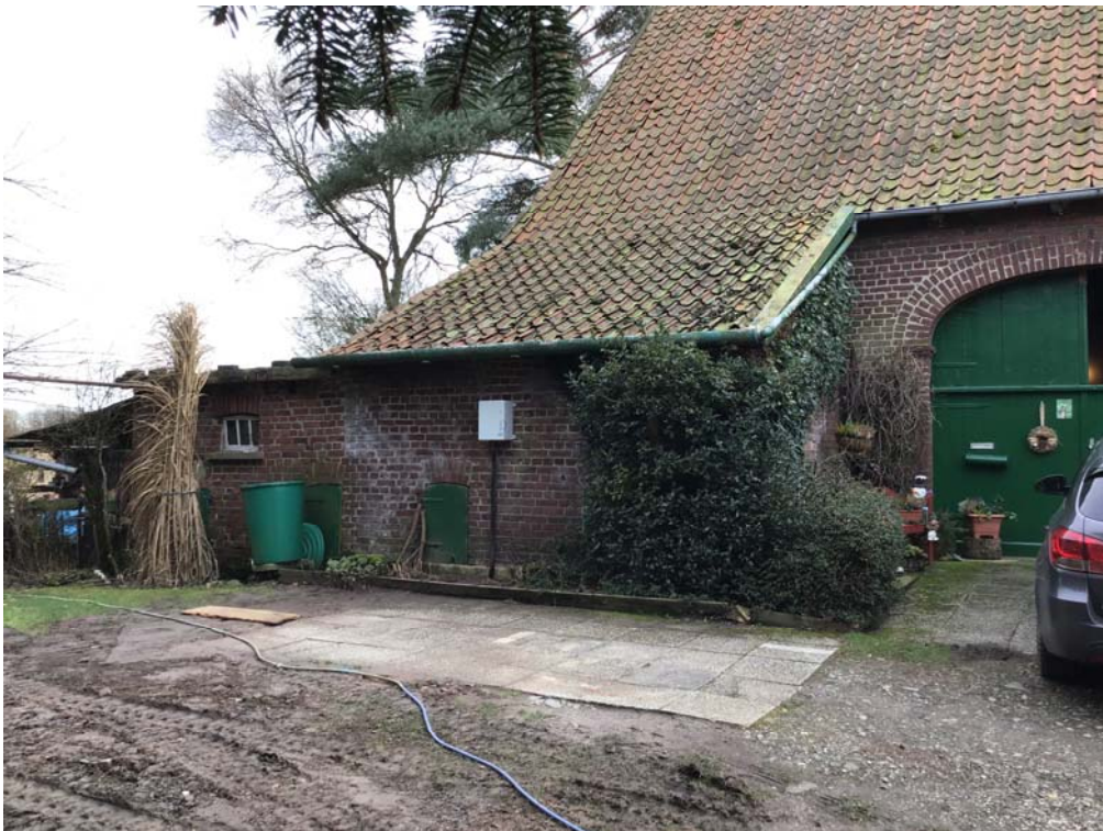
Foto 6: Blick auf die in Richtung Norden ausgerichtete Hausfront (östlicher Teil) des Wohnhauses W03
