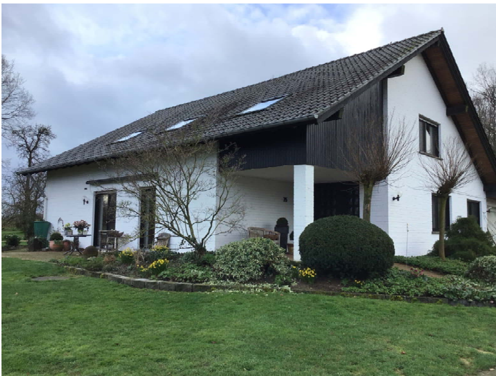
Foto 2: Blick auf die in Richtung Nordwesten und Nordosten ausgerichteten Hausfronten des Wohnhauses W01
