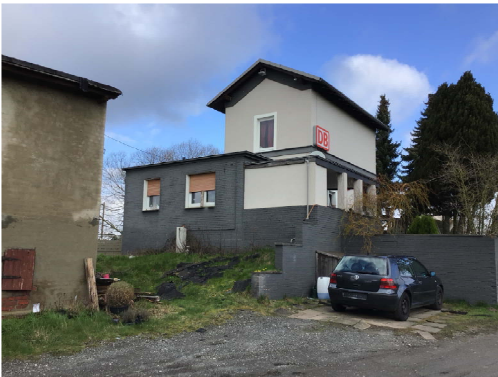
Foto 33: Blick auf die in Richtung Südwesten ausgerichtete Hausfront des Wohnhauses W16
