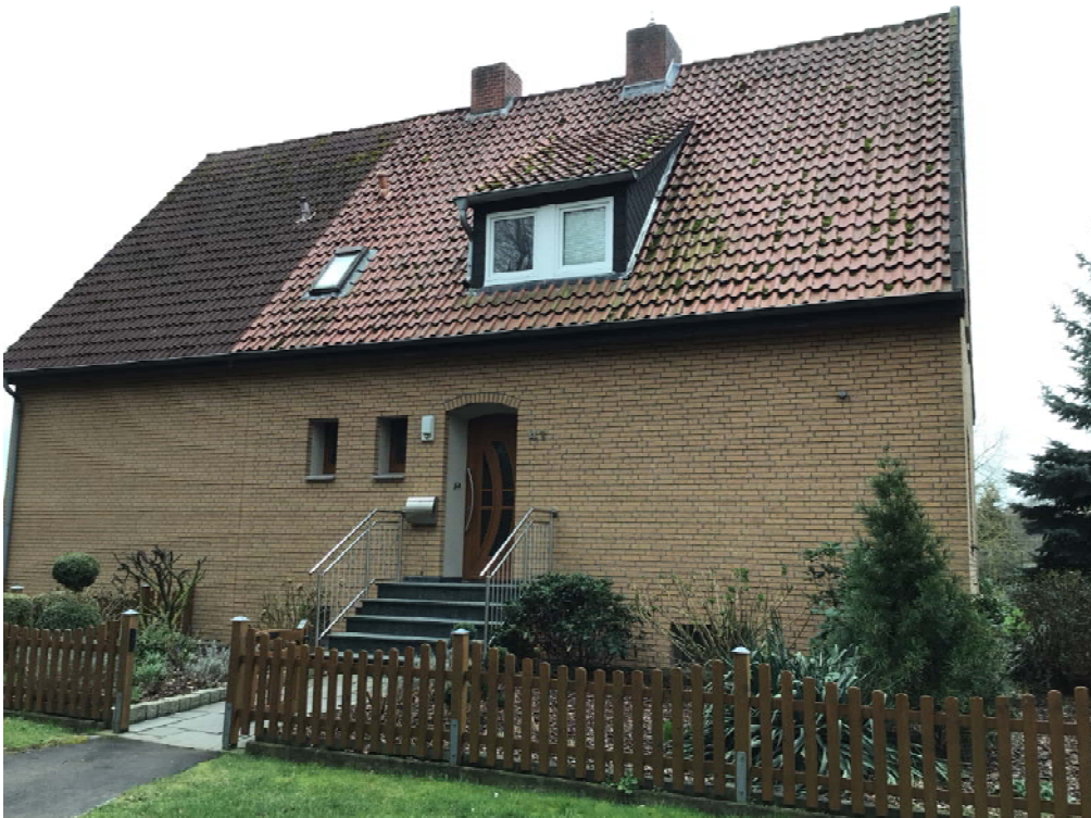
Foto 17: Blick auf die in Richtung Nordosten ausgerichtete Hausfront des Wohnhauses W08
