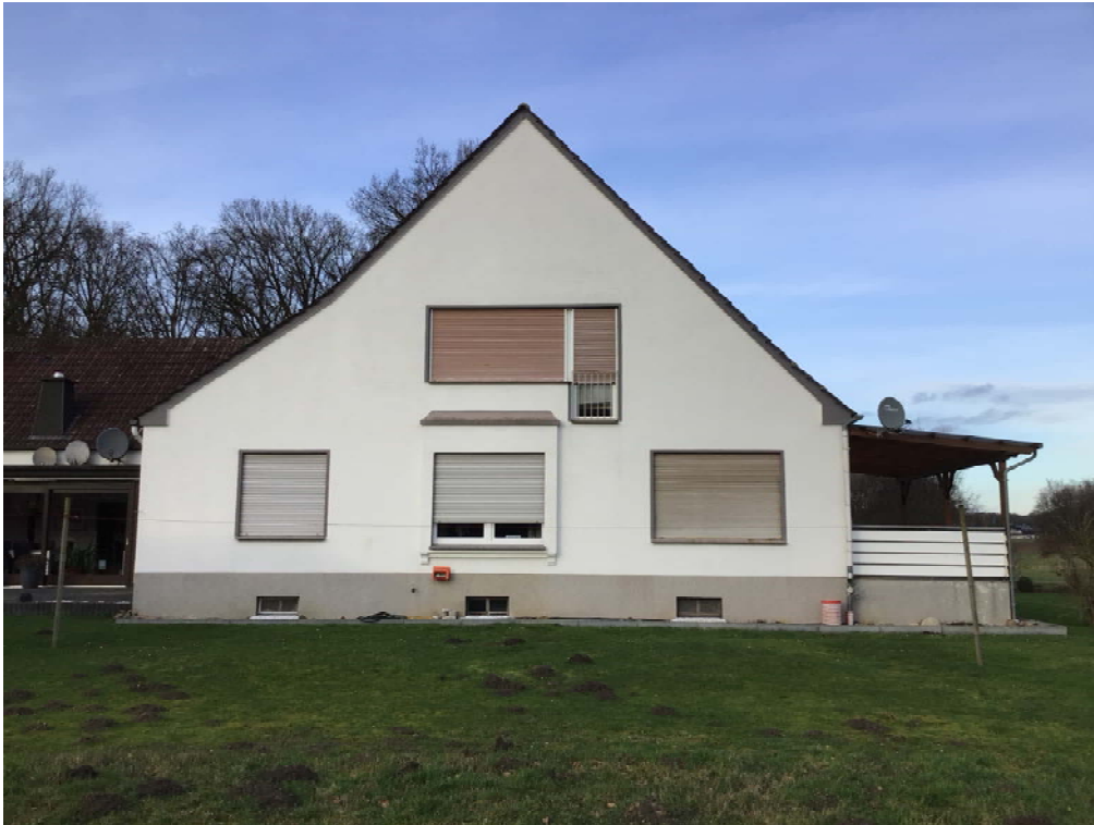
Foto 22: Blick auf die in Richtung Südwesten ausgerichtete Hausfront (östlicher Teil) des Wohnhauses W11
