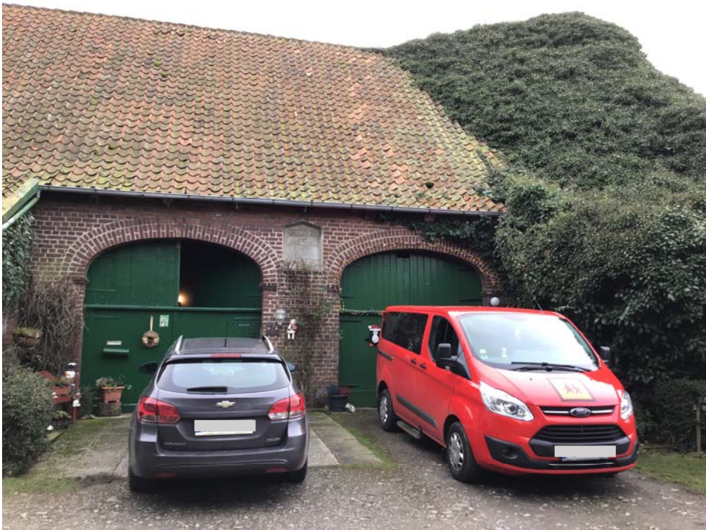
Foto 5: Blick auf die in Richtung Norden ausgerichtete Hausfront (westlicher Teil) des Wohnhauses W03
