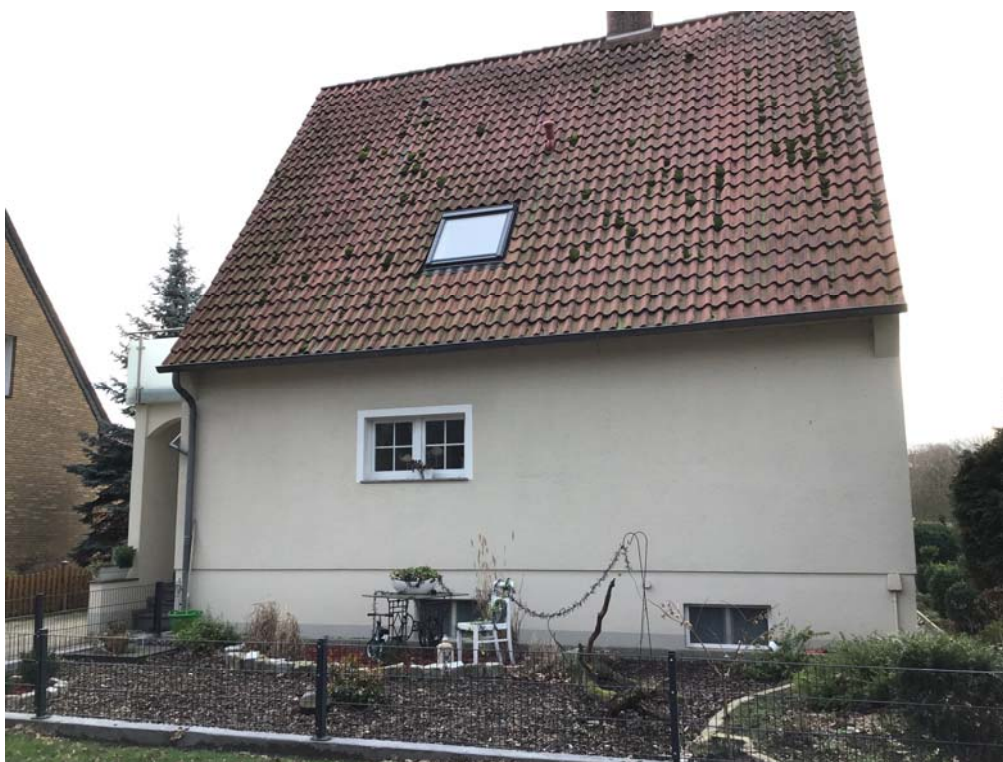
Foto 15: Blick auf die in Richtung Nordosten ausgerichtete Hausfront des Wohnhauses W07
