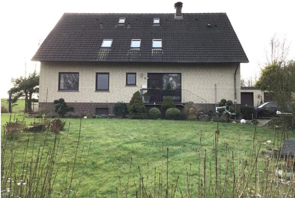
Foto 3: Blick auf die in Richtung Nordosten ausgerichtete Hausfront des Wohnhauses W02
