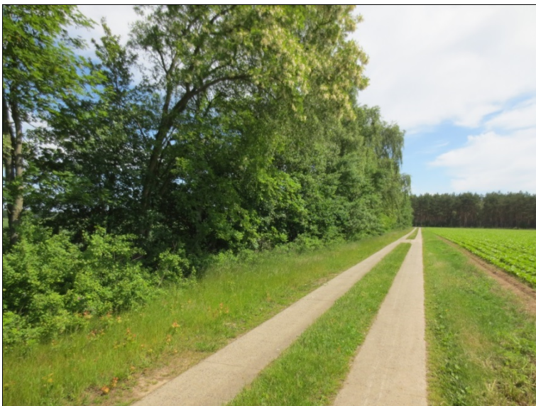
Abbildung 44: aus Betonplatten und unbefestigtem Mittelstreifen bestehender Weg auf Nienwohlder Gemarkung
