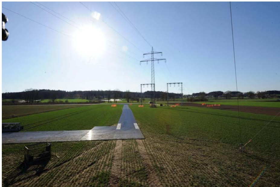
Abbildung 8: Provisorische Zuwegung als Plattenzufahrt bei einer Freileitungsbaustelle
