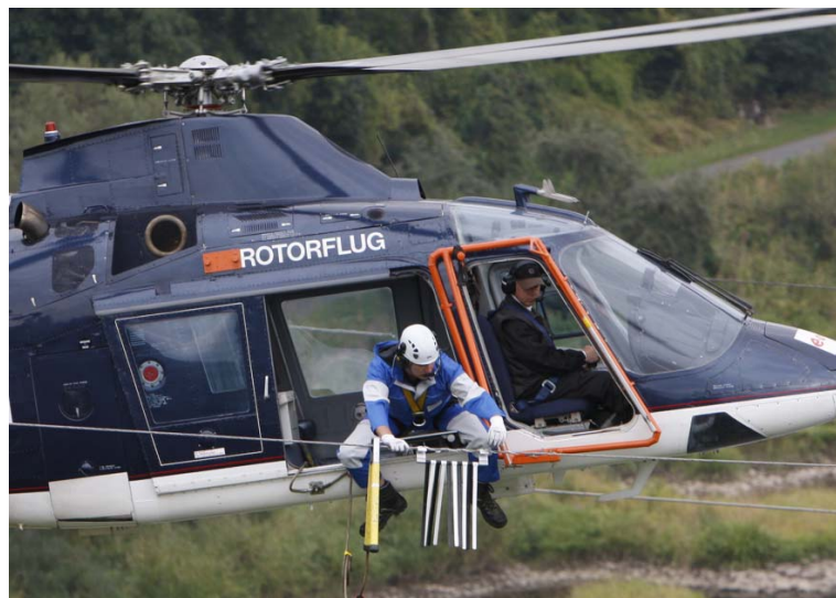
Abbildung 5: Exemplarische Darstellung der Erdseilmarkierung
