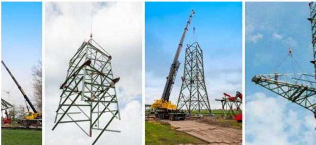
Abbildung 10: Stocken eines Freileitungsmastes
