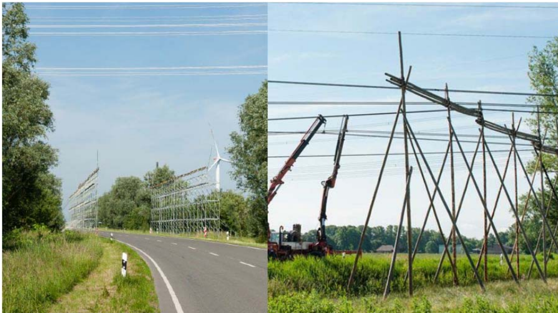
Abbildung 12: Beispiele für Schutzgerüste aus Stahl und Holz
