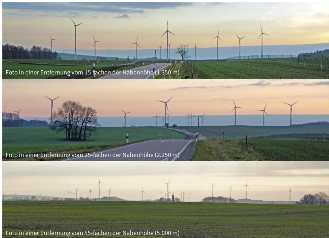
Abbildung 38 Optischer Dominanzbereich von WEA am Beispiel einer Windfarm in Mittelsachsen (Quelle: TU Dresden, Lachor © BfN (2018))
