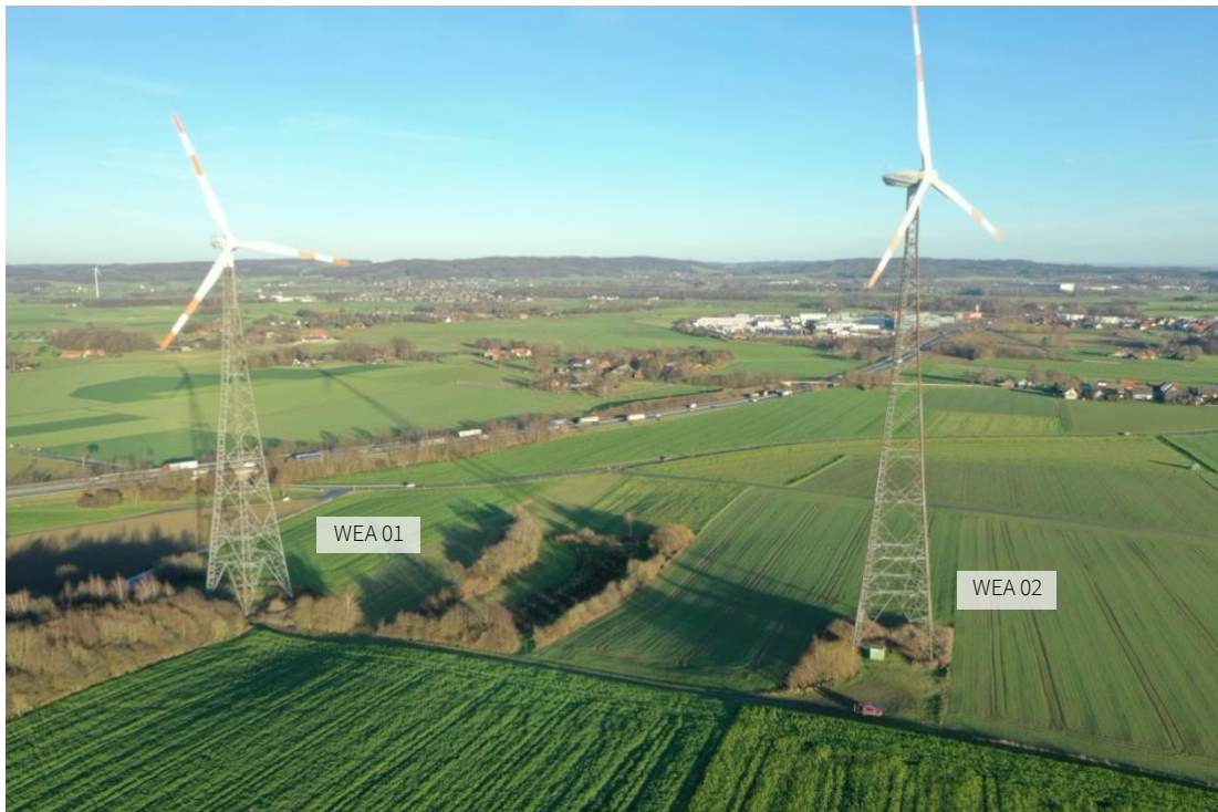
Abbildung 37 Blick auf die bestehenden WEA am Standort „Melle Dratum“
