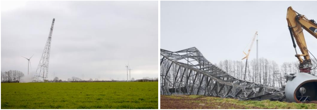
Abbildung 8 Bilder der Sprengung (links) und Demontage eines Gittermastturmes einer Vestas V47 in Bremen © Deutsche Windtechnik
