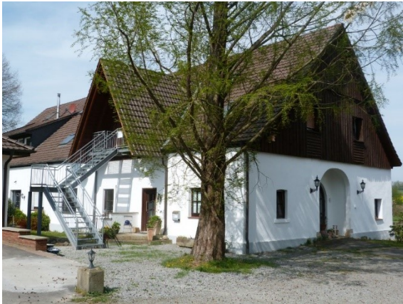
Abbildung A.9: IO 9, Üdinghauser Straße 24
