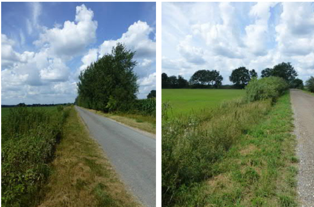
Abb. 9: betroffene Gräben entlang der Zuwegungen in den Windparks „Alstedt/Ebersdorf“
