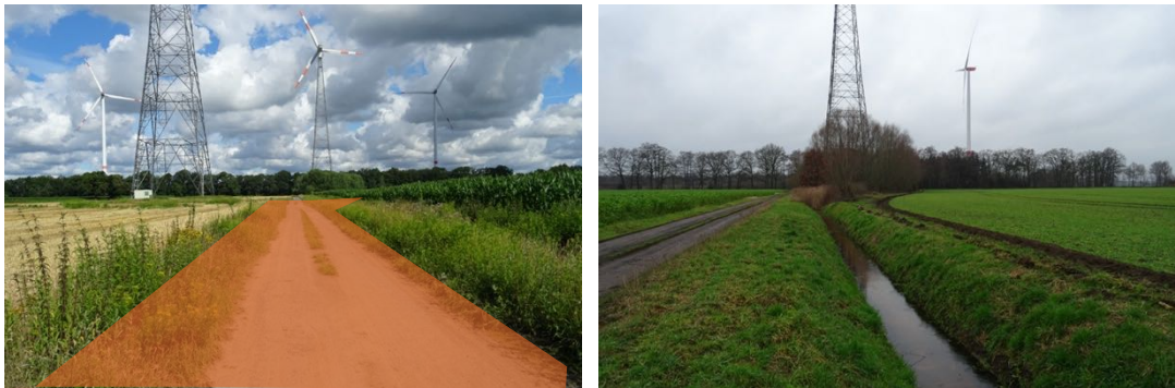
Abbildung 58 Bestehender Weg zur WEA Bad11 (links) und zu querender Graben parallel zum Weg (im Hintergrund zu sehen ist die WEA Bad11 und Bad14) (rechts)
