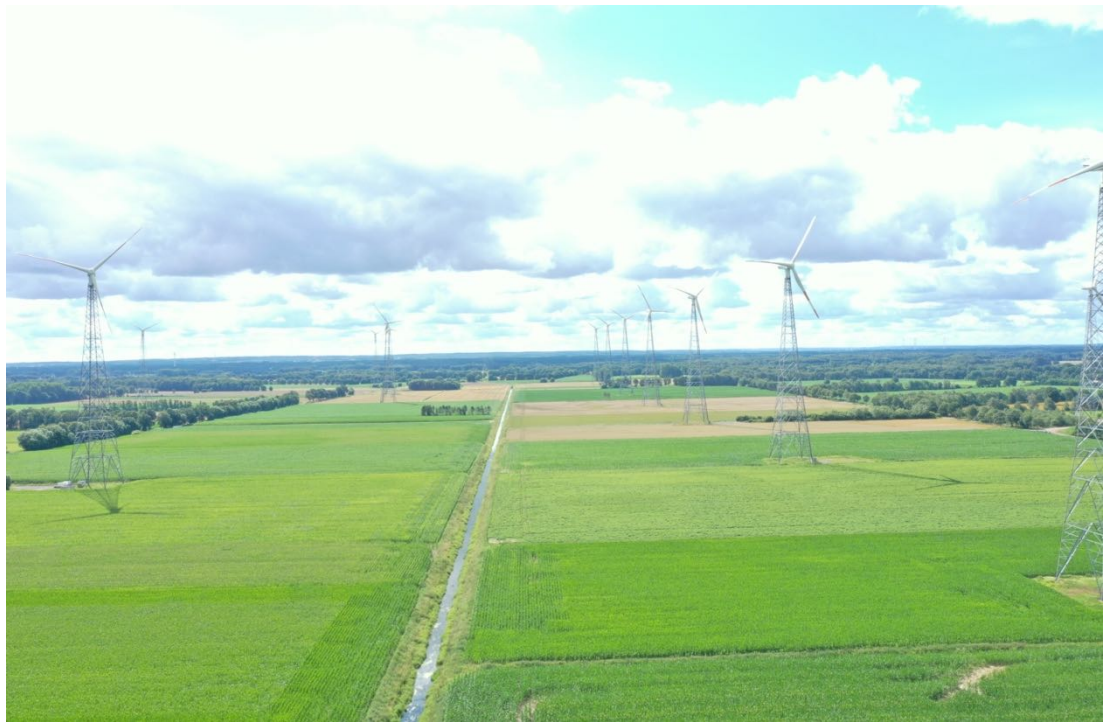
Abbildung 31 Stark begradigter Bünne-Wehdeler Grenzkanal im Zentrum des UG
