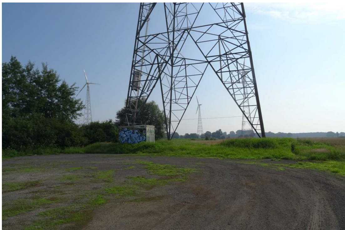
Abbildung 76 Blick auf den Mastfußbereich der WEA Bad04
