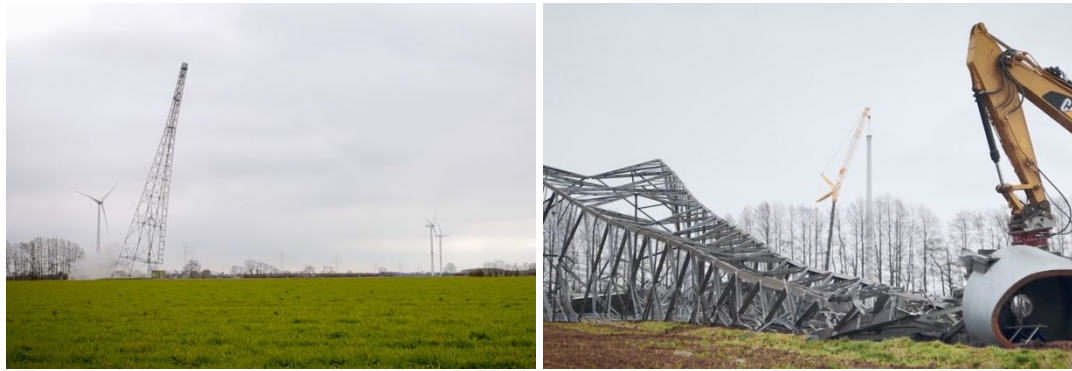
Abbildung 11 Bilder der Sprengung (links) und Demontage eines Gittermastturmes (rechts) einer Vestas V47 in Bremen © Deutsche Windtechnik
