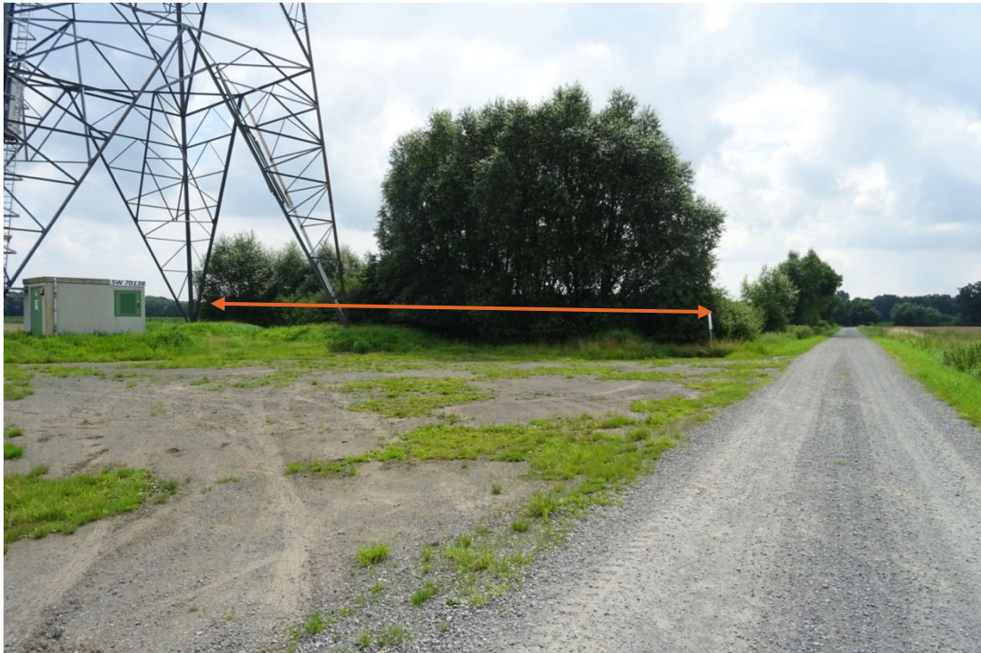
Abbildung 81 Kranstellfläche der WEA Din04 mit der angrenzenden Gehölzpflanzung
