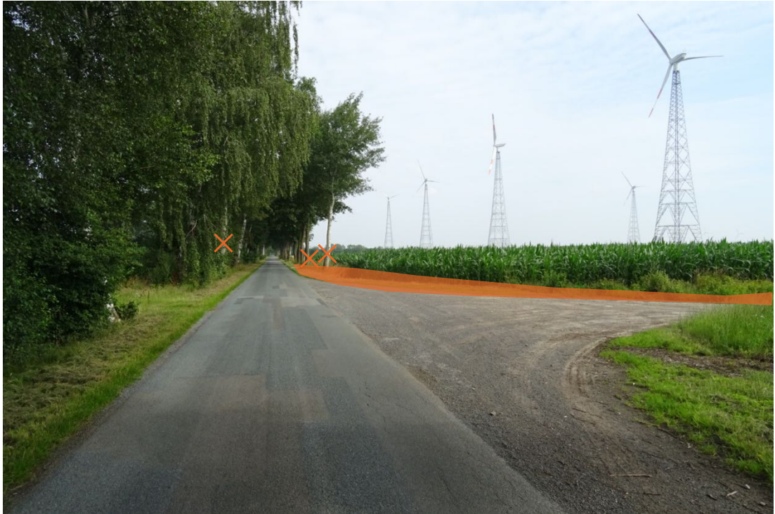
Abbildung 65 Einfahrt zur bestehenden WEA Bad02 sowie zu entfernende Bäume
