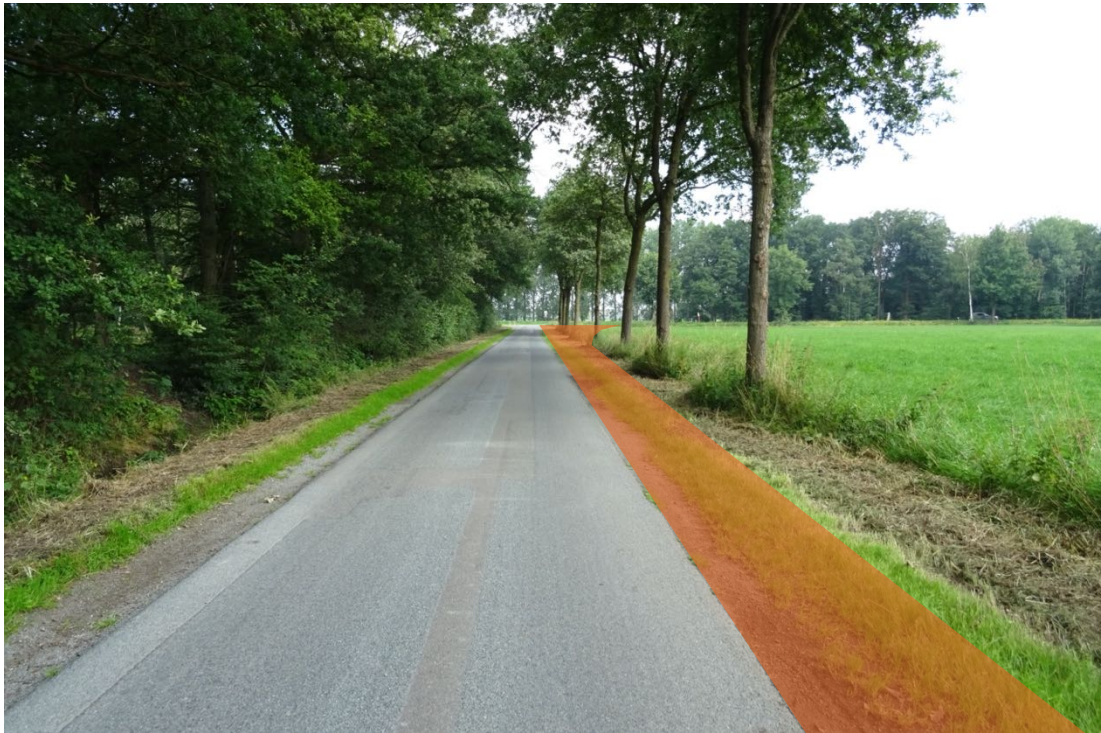
Abbildung 53 Wehdelerfeldstraße nördlich der Bestands-WEA Bad14 (N117) mit Blick Richtung Norden (mit Darstellung der Ausbauplanung); die straßenbegleitenden Bäume müssen gerodet werden
