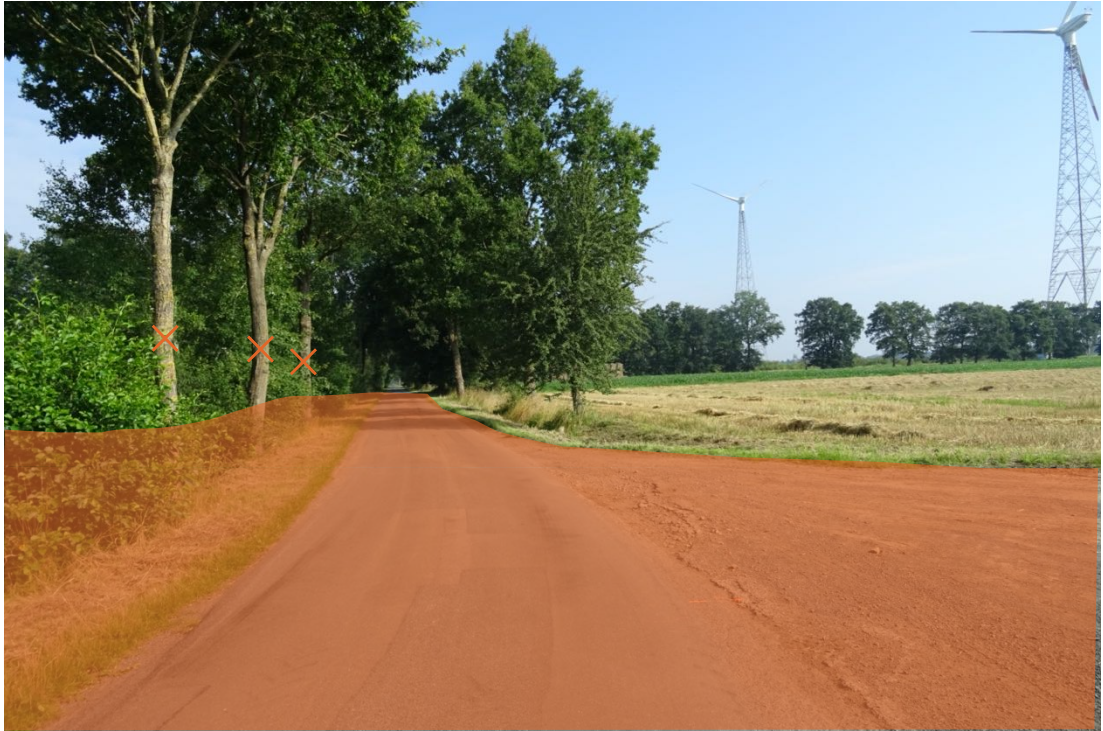
Abbildung 66 Einfahrt zur bestehenden WEA Bad07, die für die Erschließung des geplanten Standortes der WEA 8 ausgebaut werden soll.
