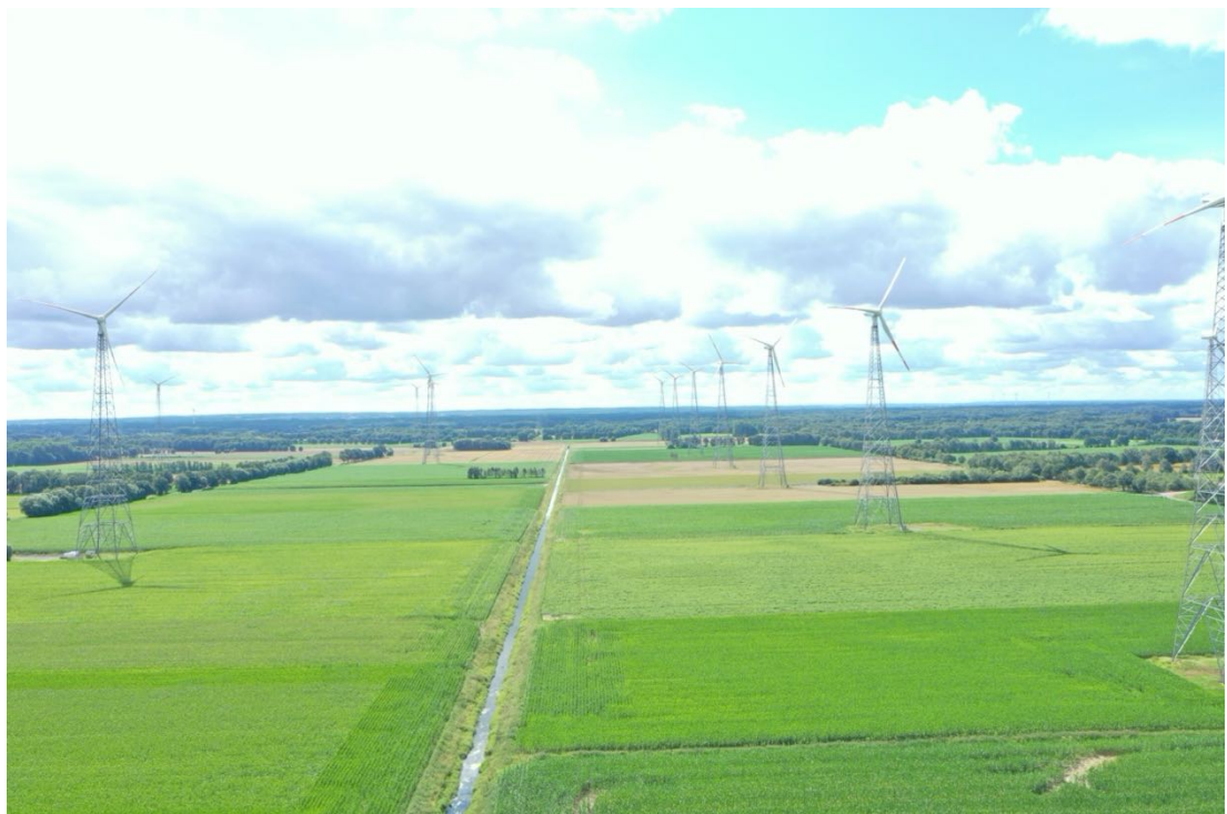
Abbildung 44 Blick auf den geraden Verlauf des Bünner-Wehdeler-Grenzkanals
