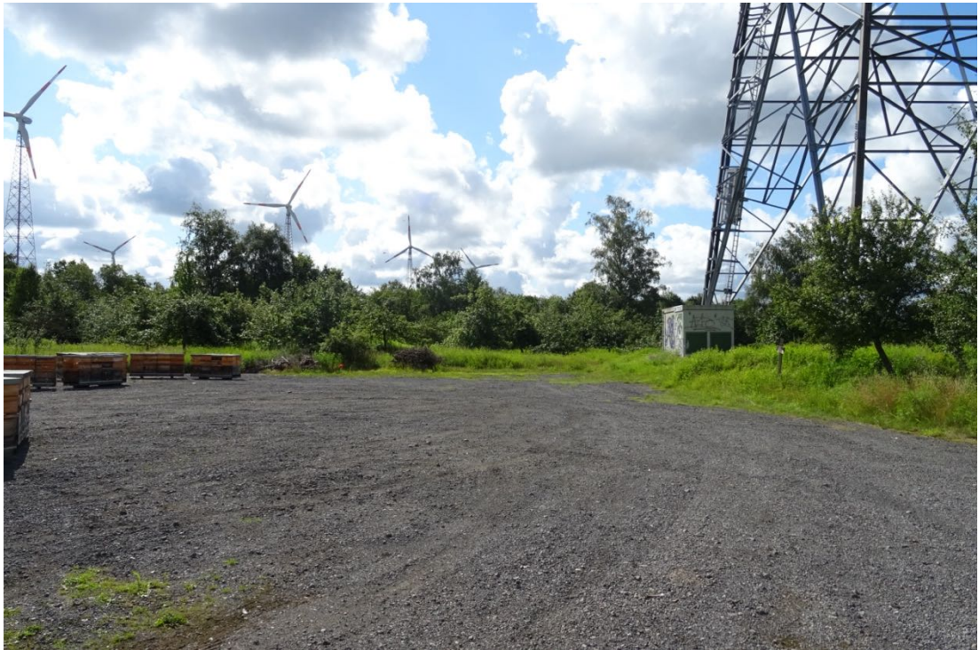
Abbildung 78 Kranstellfläche der WEA Bad12 sowie umliegende Obstbäume
