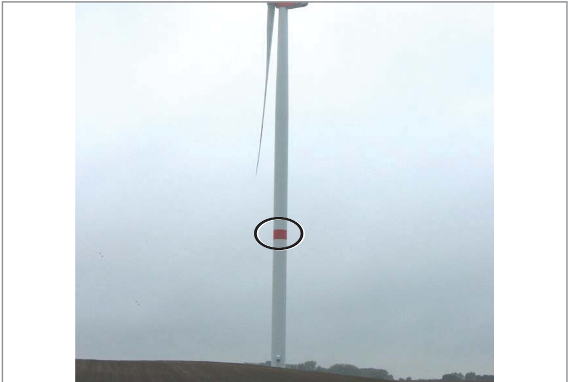
Abb. 5: Roter Farbring an Anlage mit Gesamthöhe > 150 m
