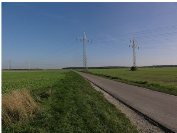
Abb. 5-6: Weithin sichtbare Hochspannungsleitungen im UG
