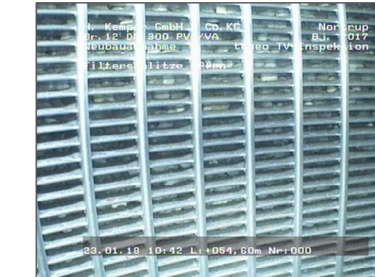
2_18A Filterschütze (aufgenommen bei 54,6 m)
