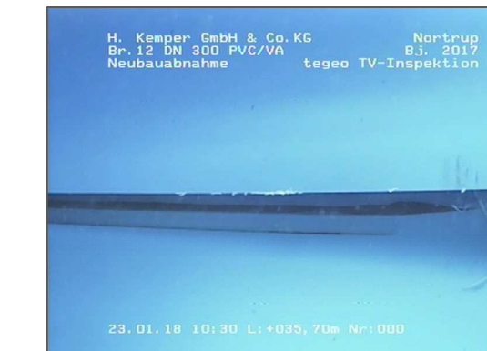
2_11A Rohrverbindung (aufgenommen bei 35,7 m)
