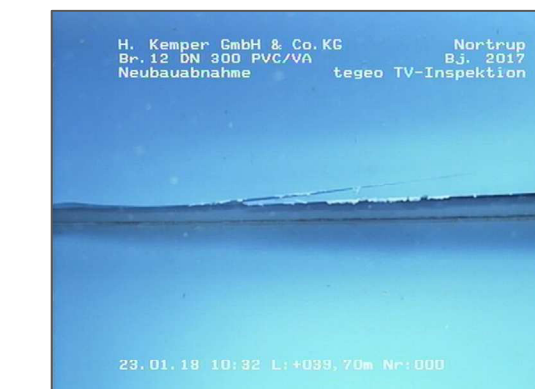
2_12A Rohrverbindung (aufgenommen bei 39,7 m)
