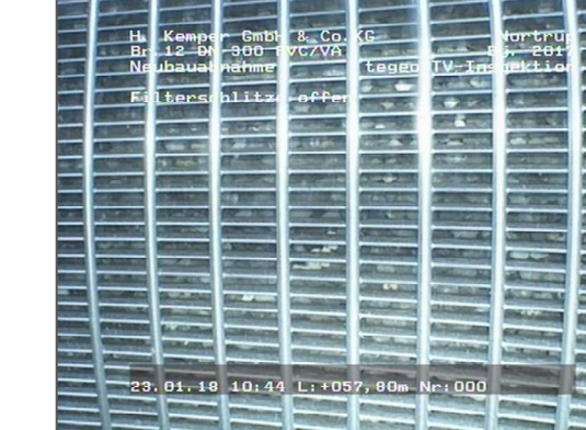
2_20A Filterschütze (aufgenommen bei 57,8 m)
