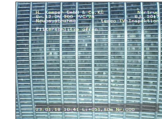
2_17A Filterschütze (aufgenommen bei 51,8 m)
