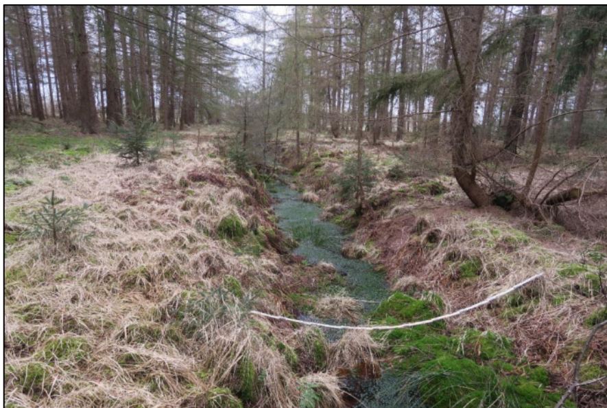
Abb. 4: Sonstiger vegetationsarmer Graben im Bereich der geplanten Verrohrung.
