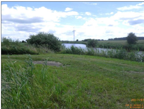
Abb. 12: Bereich des geplanten Dükers zur Jade
