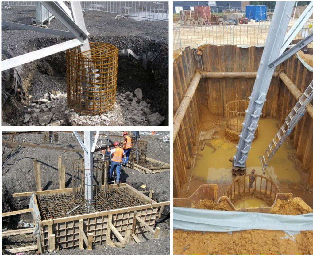
Abbildung 10: Anbindung der Eckpfähle nach dem Betonieren
