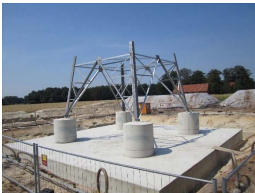
Abbildung 13: Plattenfundament vor und nach der Verfüllung der Baugrube
