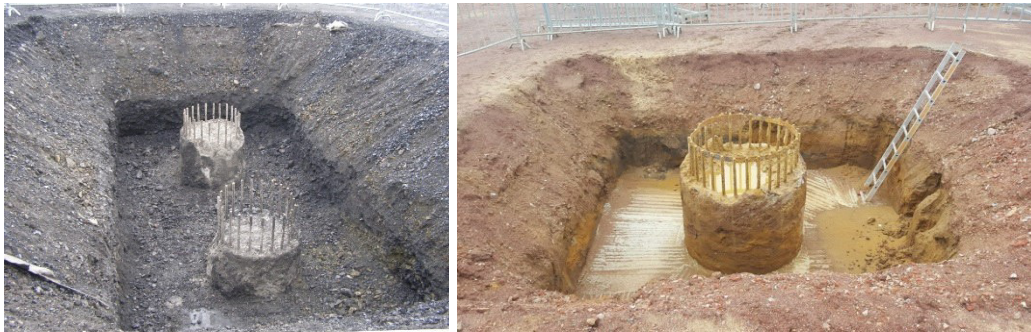
Abbildung 6: Freilegen der Bohrpfähle
