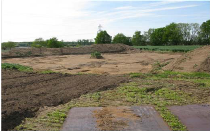
Abbildung 4: Abtrag des Oberbodens
