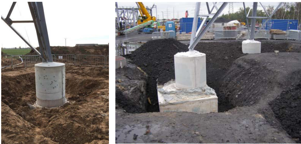
Abbildung 10: Anbindung der Eckpfähle nach dem Betonieren
