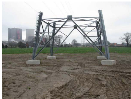
Abbildung 13: Plattenfundament vor und nach der Verfüllung der Baugrube
