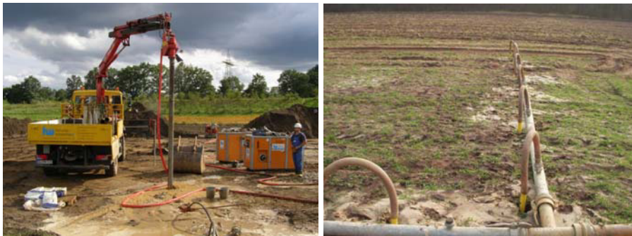
Abbildung 7: Einrichtung der Wasserhaltung mittels Spüllanzen
