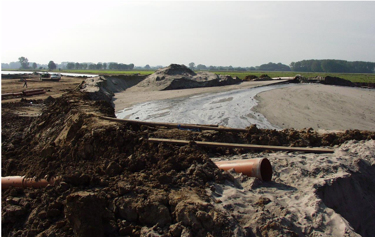
Abbildung 3: Anlegen von Spülfeldern in der Bodenentnahme Raffatz/Wilkenstorf (Foto: NLWKN - Betriebsstelle Lüneburg vom 06.10.2000)
