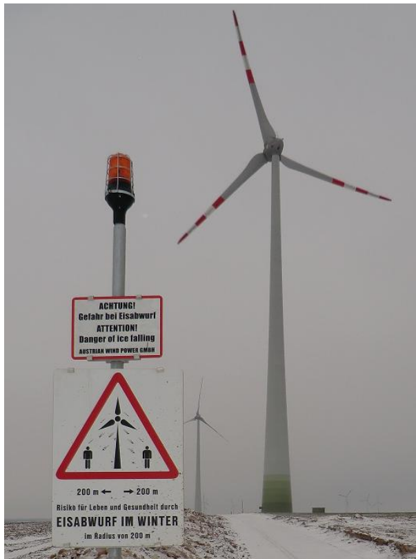
Abb. 1: Möglicher Aufbau einer Eiswarnleuchte mit zusätzlichen Warnschildern
