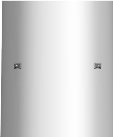
Abb. 2: Befuerungsleuchte am Turm
