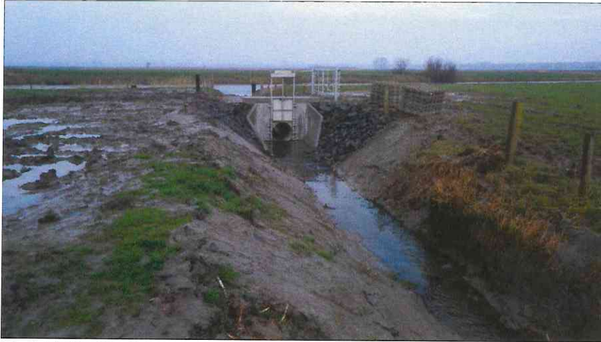
Abb. 2: Verlaat im Zuggraben (Foto: Ing.-Büro Börjes)
