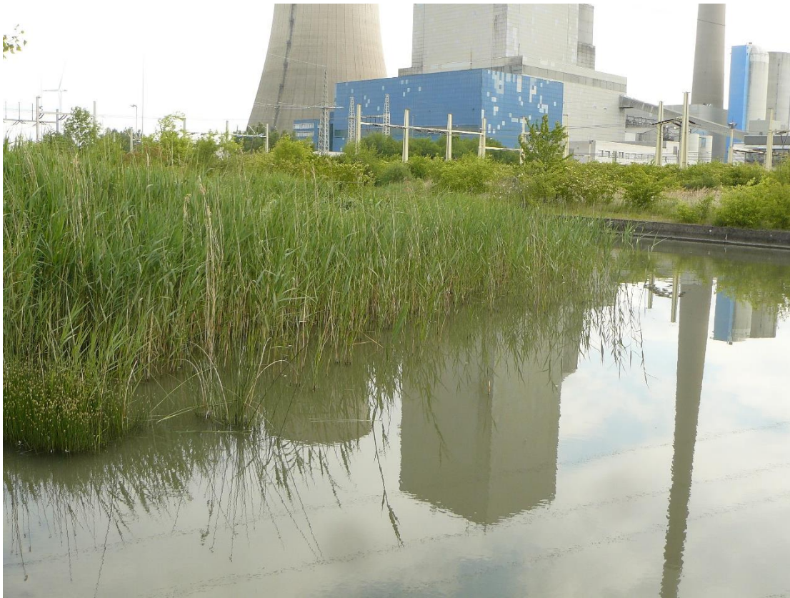
Abbildung 4: Südöstliches mit Schilf bestandenes Betonbecken (Gewässer a), Blick nach Nordosten, 01.06.2022.
