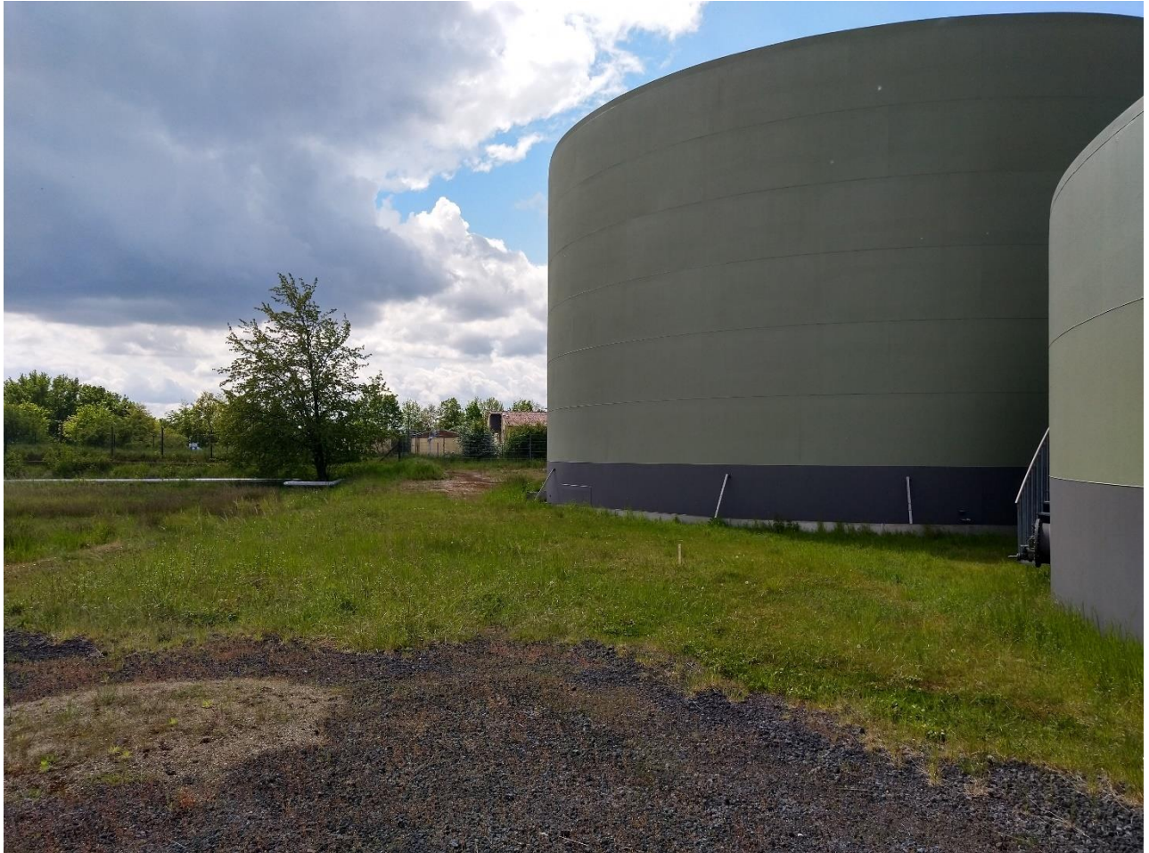
Abbildung 3: Bereich Öltanks, Blickrichtung Süd (19.05.2021)
