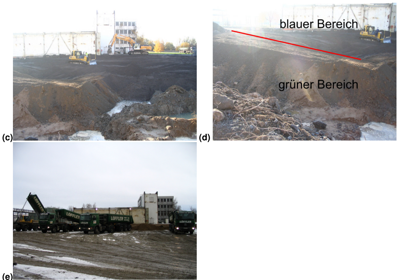
Abb. 6. a - b Entfundamentierung und Wiederverfüllung, c Wiederverfüllung mit Grobasche, d Wiederverfüllung im Bereich des ehem. Maschinen- und Kesselhauses, in rot markiert Grenze zwischen Wiederverfüllung mit Grobasche bzw. Füllsand, e Wiederverfüllung mit Mutterboden.
