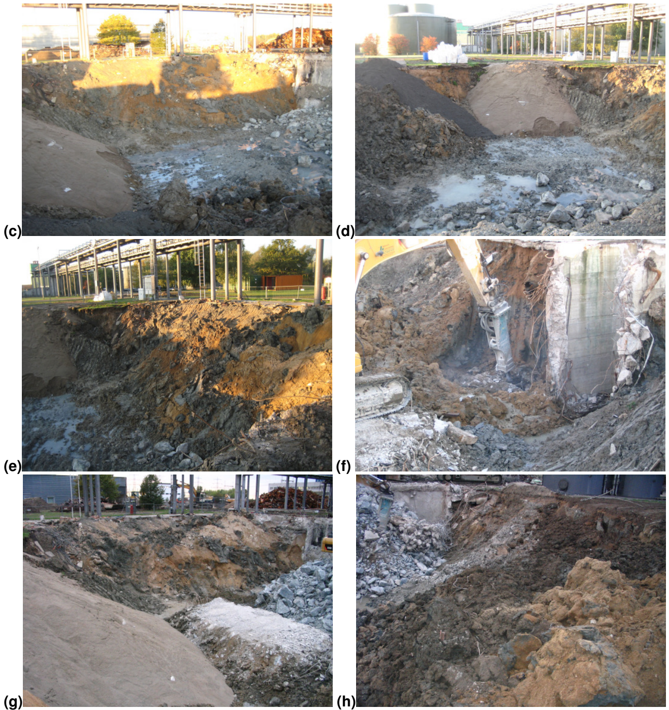
Abb. 3. a - d Entfundamentierung und Wiederverfüllung im Bereich Hilfskesselhaus bzw. Wasseraufbereitung.
