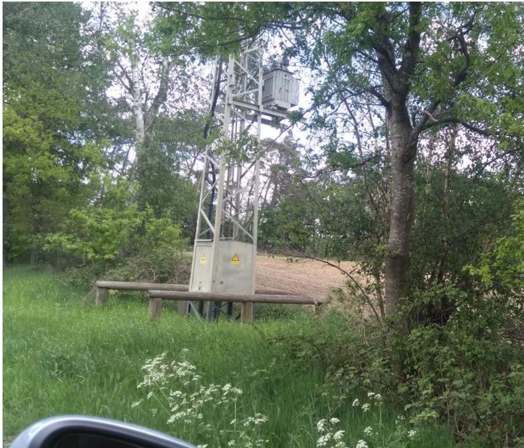
Abbildung 51: unterbrochene Verwaltung im Bereich der genannten Problemstelle
