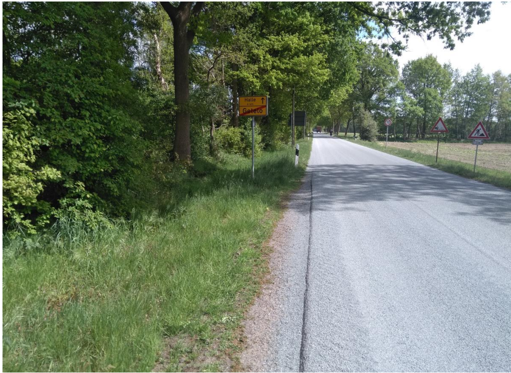
Abbildung 2: Beginn der Projektstrecke bei Getelo, Blick nach Osten
