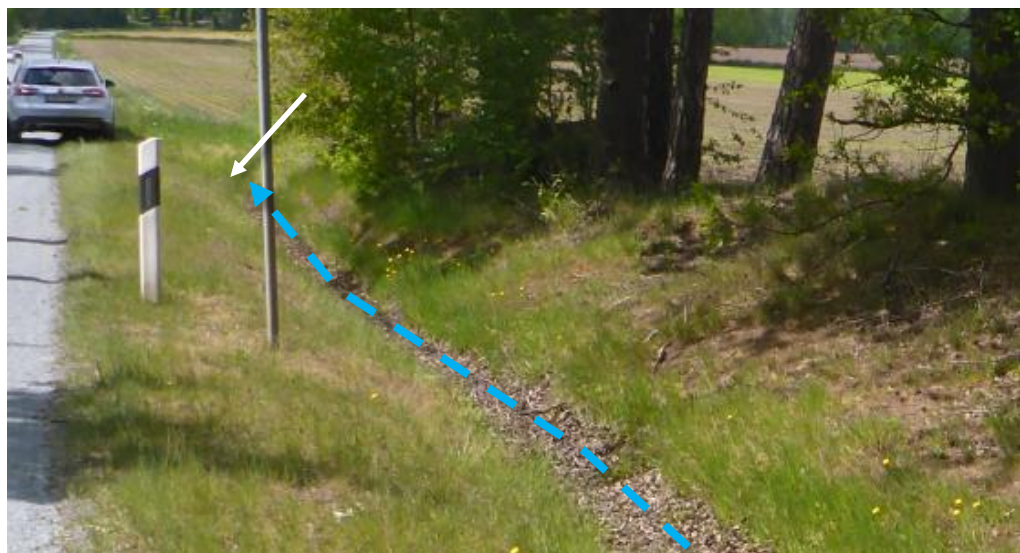
Abbildung 27: Ende der Mulde aus vorherigen Bildern ohne weitergehende Rohrleitung (siehe Pfeil)
