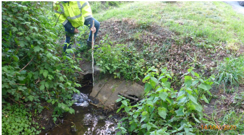
Abbildung 16: Durchlässe (2x DN500) für namenloses Gewässer zur Kreuzung der K40
