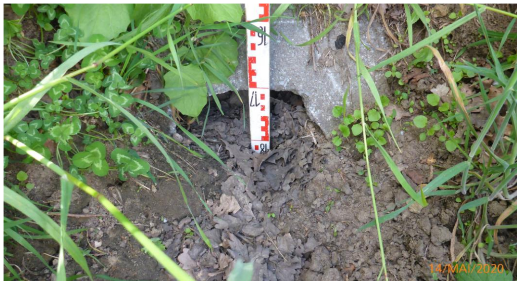
Abbildung 14: Verlandeter Durchlass
