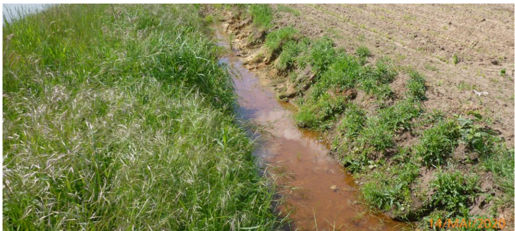
Abbildung 29: Versickerungsgraben bzw. Mulde westlich von Halle mit nicht abfließender Wasserführung
