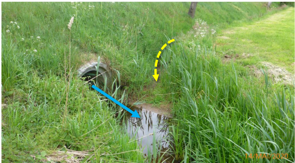
Abbildung 19: Durchlass (DN800) des Ultgrabens (Fließrichtung siehe blauer Pfeil) durch K40 mit einmündendem „Versickerungsgraben“ (gelber Pfeil)
