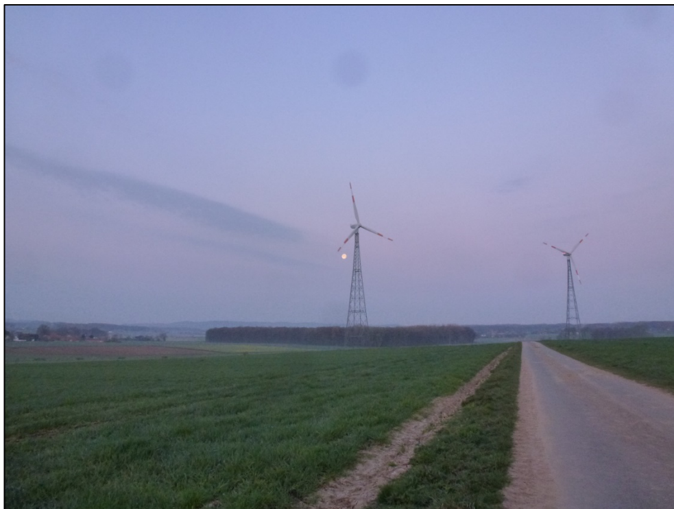
Blick auf die WEA-Altanlagen von Osten
