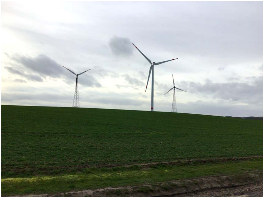
Bild 14: W04a - Darstellung der Sichtbeziehung mit bestehenden und geplanten WEA
