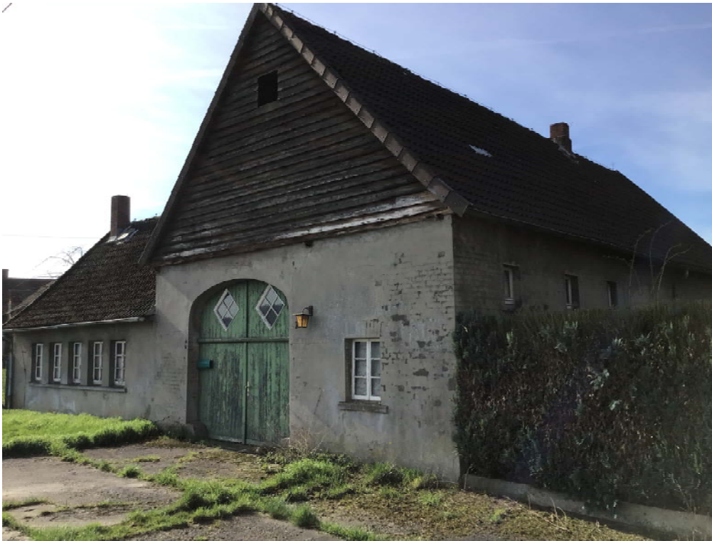
Foto 16: Blick auf die in Richtung Nordosten und Nordwesten (östlicher Teil) ausgerichteten Hausfronten des unbewohnten Wohnhauses W08
