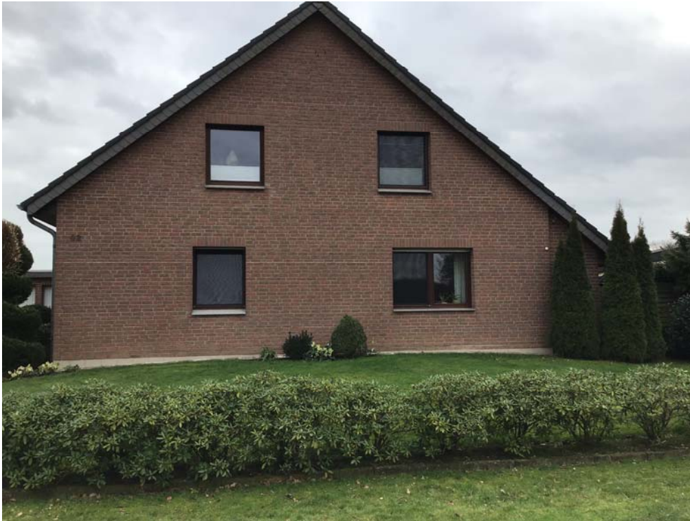
Foto 5: Blick auf die in Richtung Nordwesten ausgerichtete Hausfront des Wohnhauses W03
