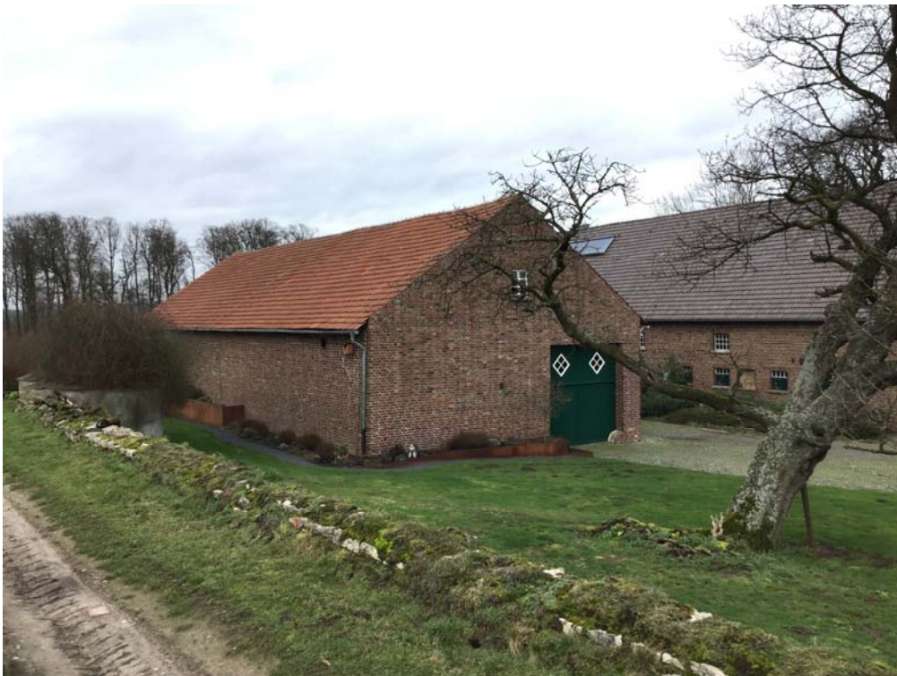
Foto 8: Blick auf die in Richtung Südwesten und Südosten ausgerichtete Front eines Nebengebäudes, das dem Wohnhaus W04 vorgelagert ist
