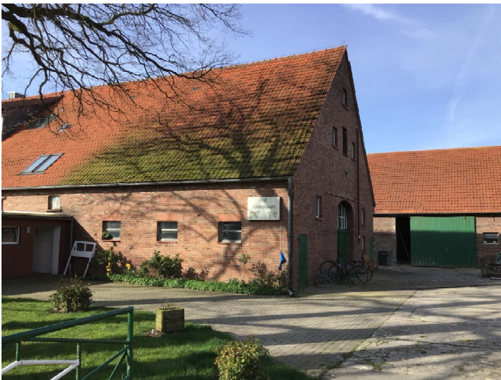
Foto 13: Blick auf die in Richtung Osten ausgerichtete Hausfront des Wohnhauses (nördlicher Teil ohne Wohnnutzung) W06
