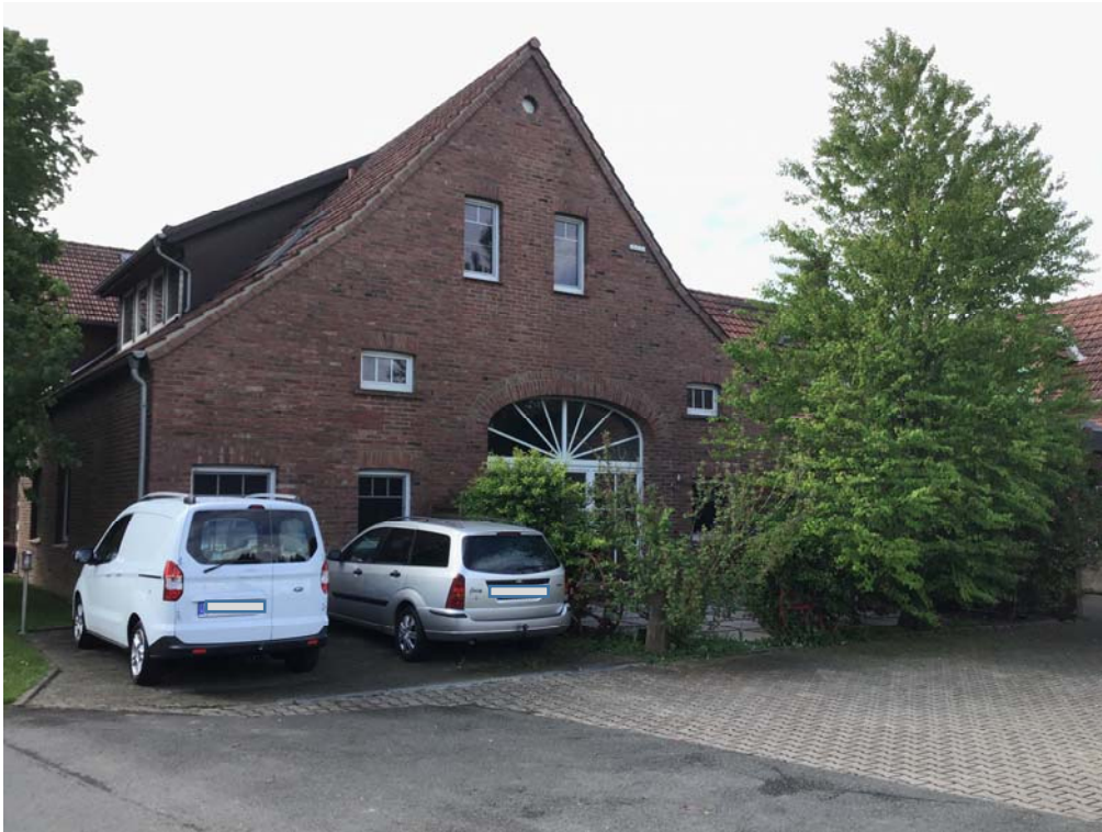
Foto 19: Blick auf die in Richtung Nordwesten ausgerichtete Hausfront des Wohnhauses W10
