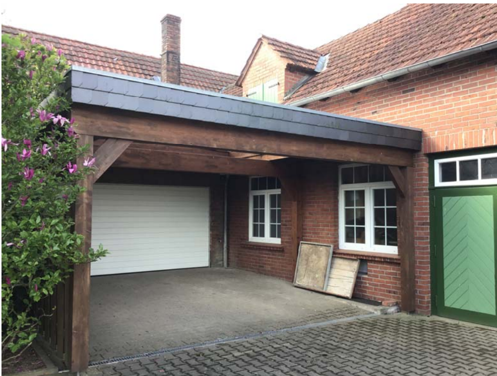
Foto 20: Blick auf Garage und Nebengebäude, die westlich an das Wohnhaus W10 anschließen
