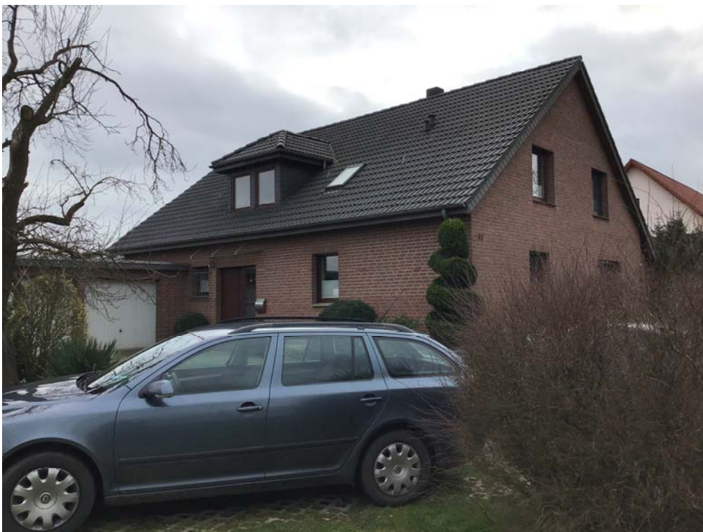
Foto 6: Blick auf die in Richtung Nordosten ausgerichtete Hausfront des Wohnhauses W03
