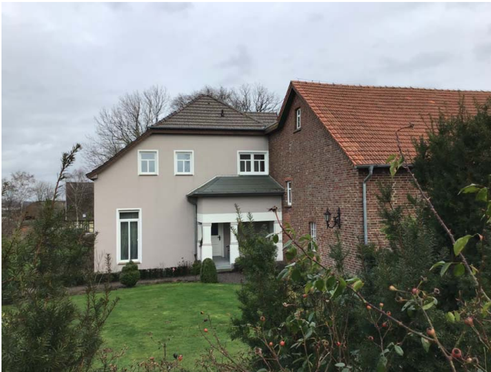
Foto 7: Blick auf die in Richtung Südwesten ausgerichtete Hausfront (nördlicher Teil) des Wohnhauses W04
