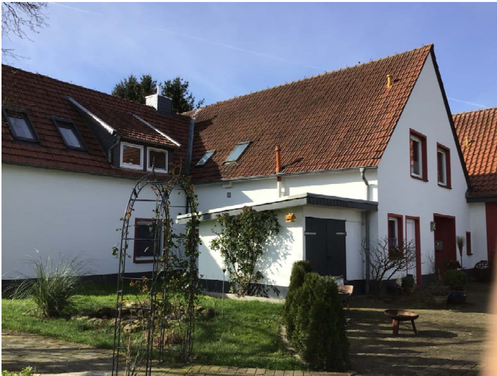
Foto 14: Blick auf die in Richtung Nordwesten ausgerichtete Hausfront (östlicher Teil) des Wohnhauses W07
