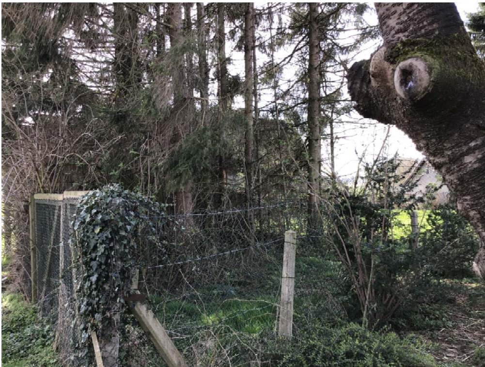
Foto 17: Blick von der nördlichen Grundstücksgrenze auf die in Richtung Nordwesten ausgerichtete Hausfront des unbewohnten Wohnhauses W08
