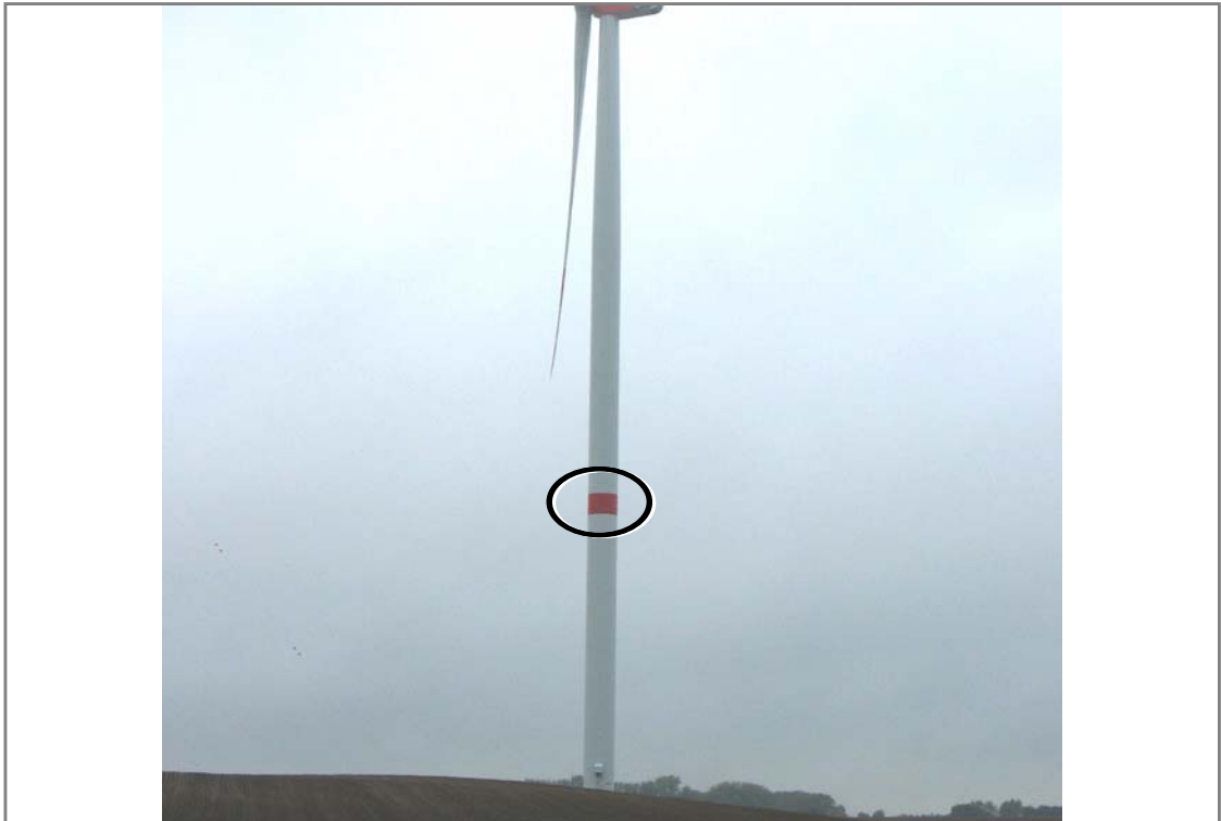
Abb. 5: Roter Farbring an Anlage mit Gesamthöhe > 150 m
