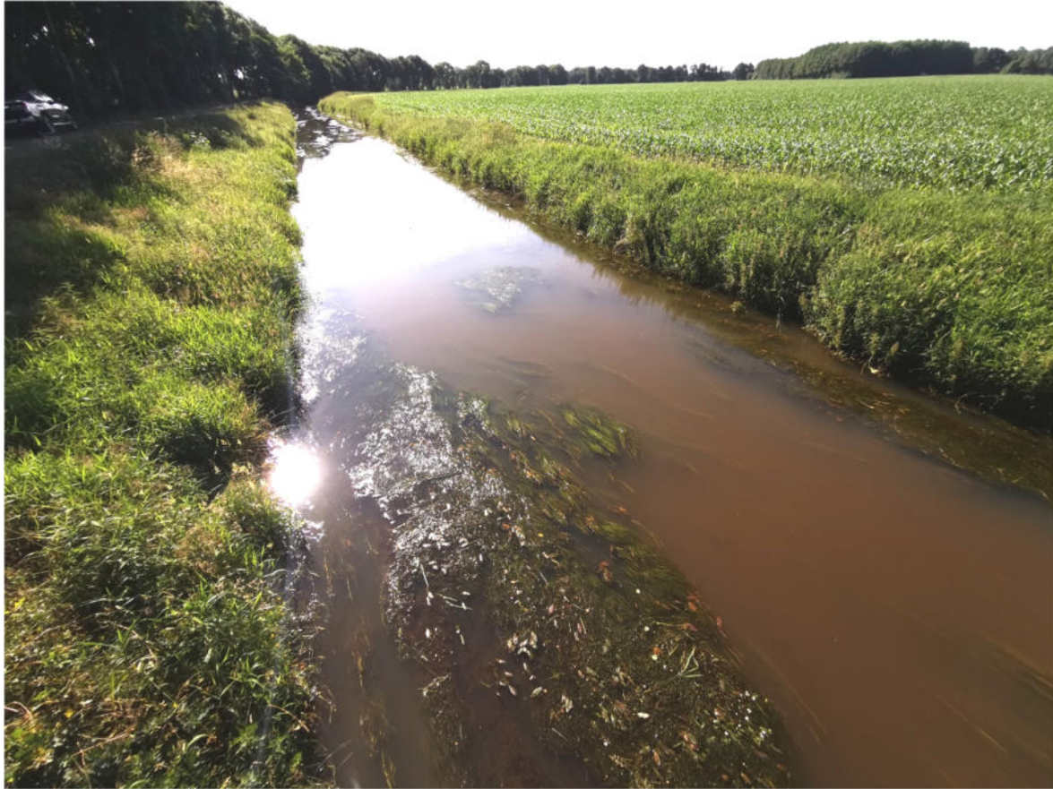
Abb. 2: Lahe, Probestelle unterhalb Kläranlage (Monitoringmessstelle); beiden Stellen mit hohen Deckungsgraden; typisch für die Lahe ist der gleichförmige Ausbau ohne Ufergehölze – 24.06.2020
