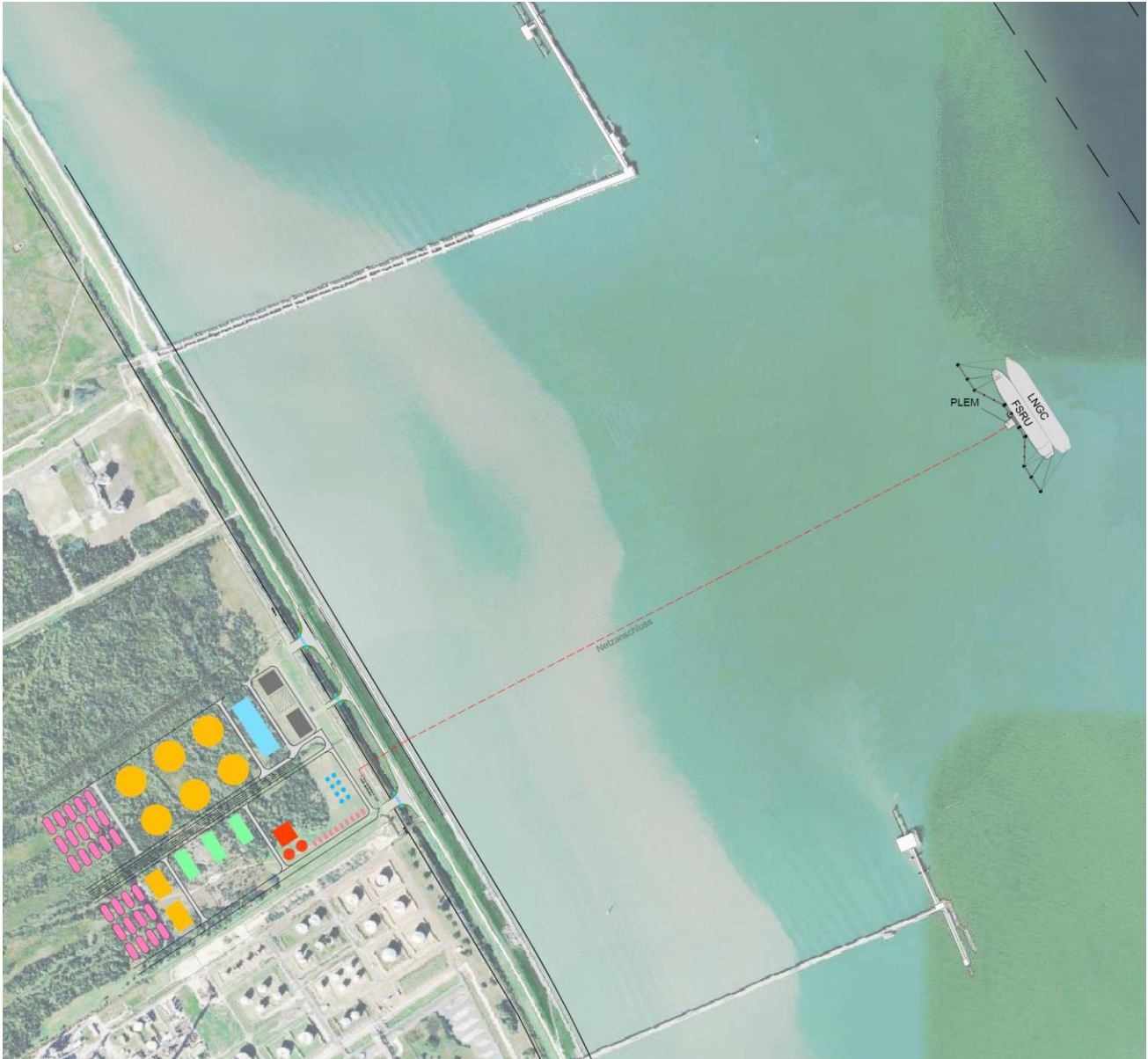
Abbildung 1-2 Detailansicht des FSRU-Terminals Wilhelmshaven
