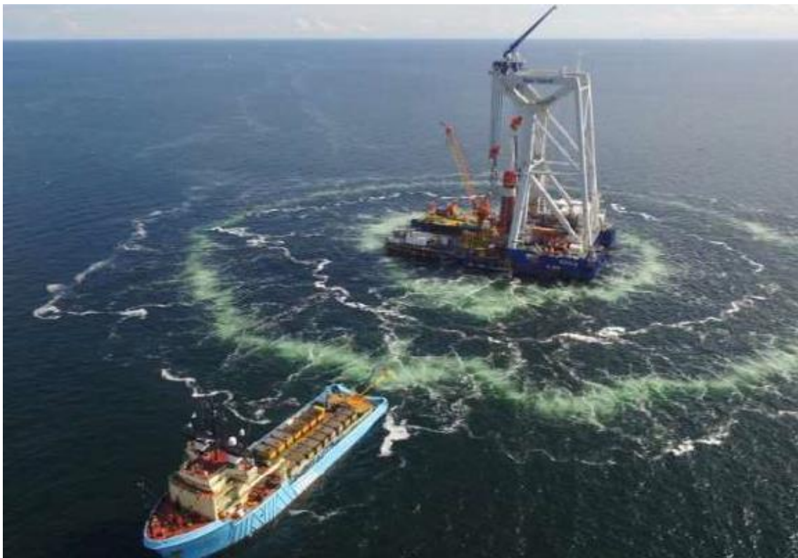
Abbildung 26 - Doppelter Blasenschleier zur Lärminderung im Einsatz
