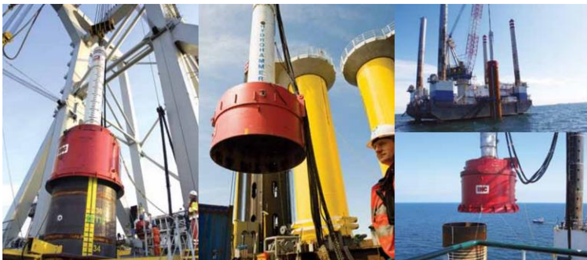
Abbildung 24 - Typischer Hydrohammer zum Rammen der Dalben (Quelle: IHC IQIP)
