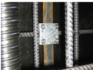
Abb. 9: Verbindung Blitzschutzzeisen mit Bewehrung
