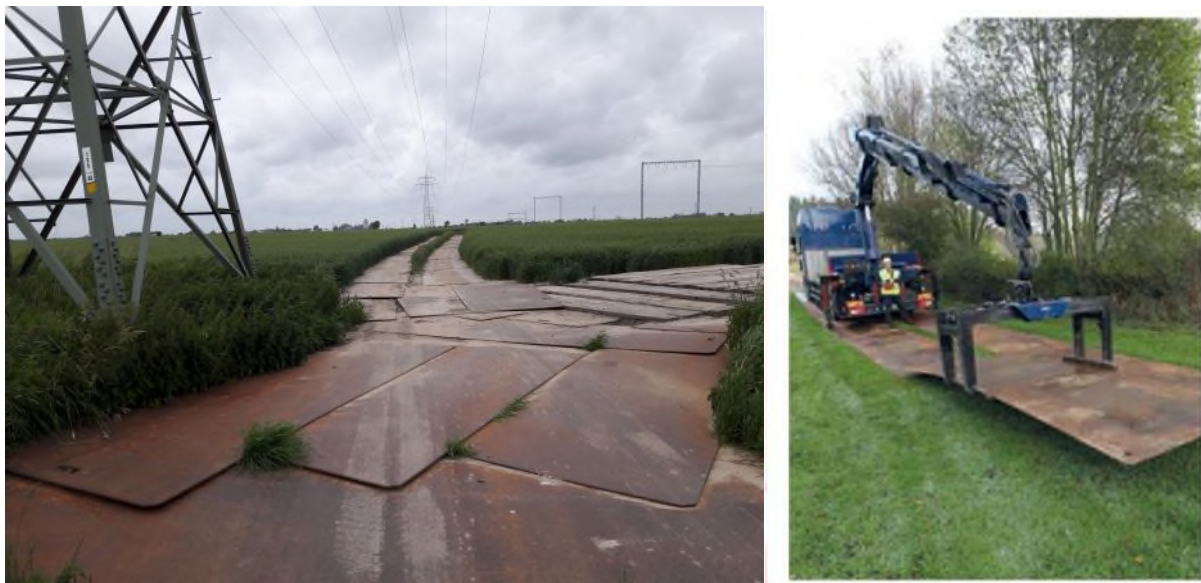
Abbildung 6: Provisorische Zuwegung mit Stahlplatten und Baggermatten und deren Einrichtung
