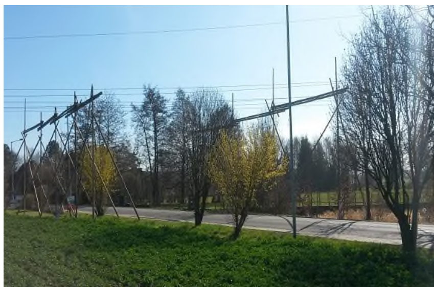
Abbildung 15: Einfaches Schleifgerüst an Kreisstraße
