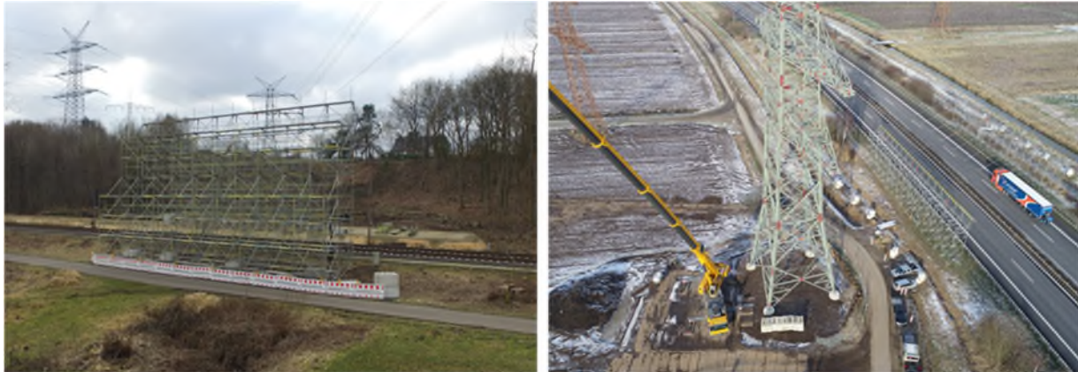
Abbildung 14: Schutzgerüste an einer Bahn und einer Autobahnkreuzung
