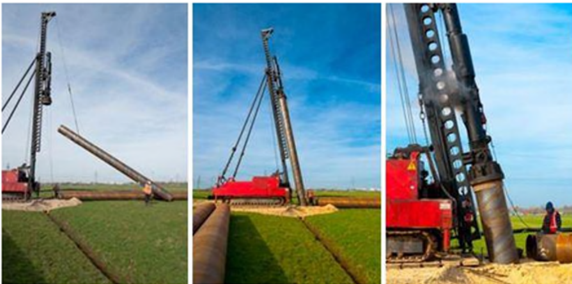
Abbildung 9: Durchführung einer Bohrpfahlgründung
