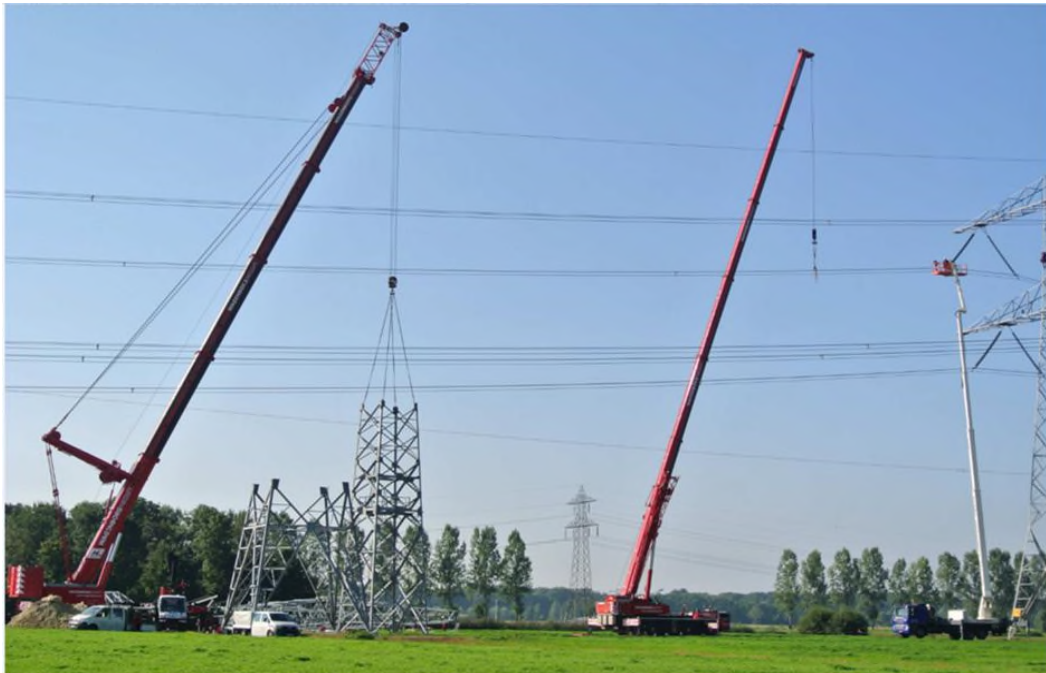
Abbildung 11: Maststocken mit Hilfe eines Mobilkrans
