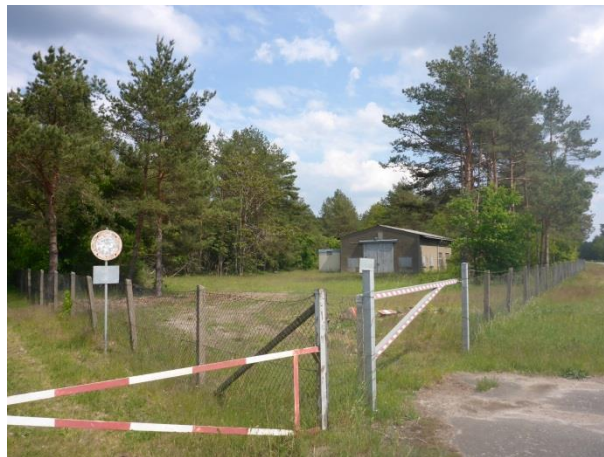
Foto 2: Bewirtschaftungsge- bäude des NLWKN am Löcknitzwehr, LBE 5
