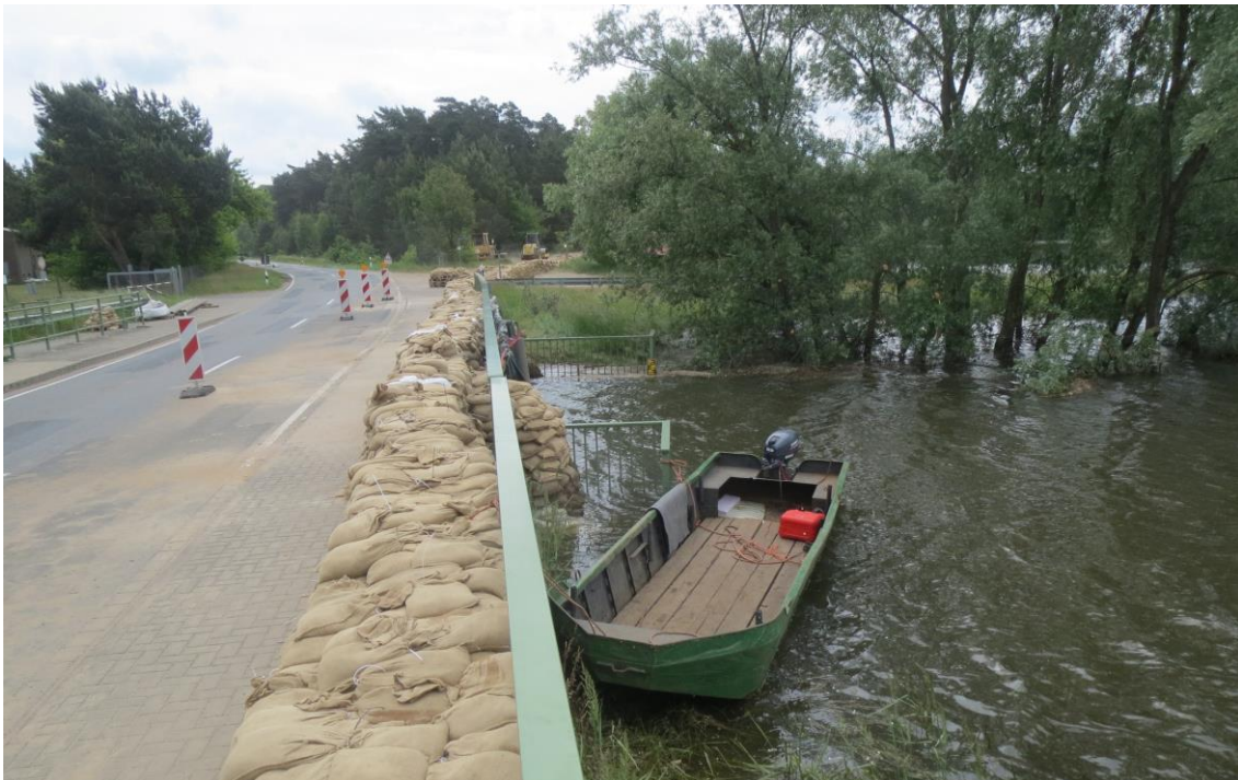
Abbildung 5: Wehranlage Wehningen - Hochwasser 13. Juni 2013; Blickrichtung zur Landesgrenze Mecklenburg-Vorpommern (Foto: Karsten Helms, NLWKN - Betriebsstelle Lüneburg)
