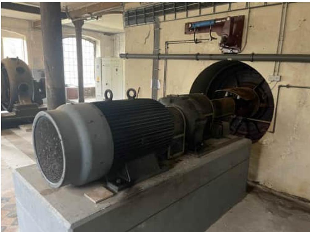
*Abbildung 12: Turbine mit Horizontaler Achse im Krafthaus der WKA Zoll*
