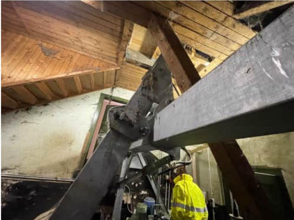
*Abbildung 9: oberer Teil der Vertikal Rechenreinigungsmaschine; Decke beschränkt Bewegungsradius*
