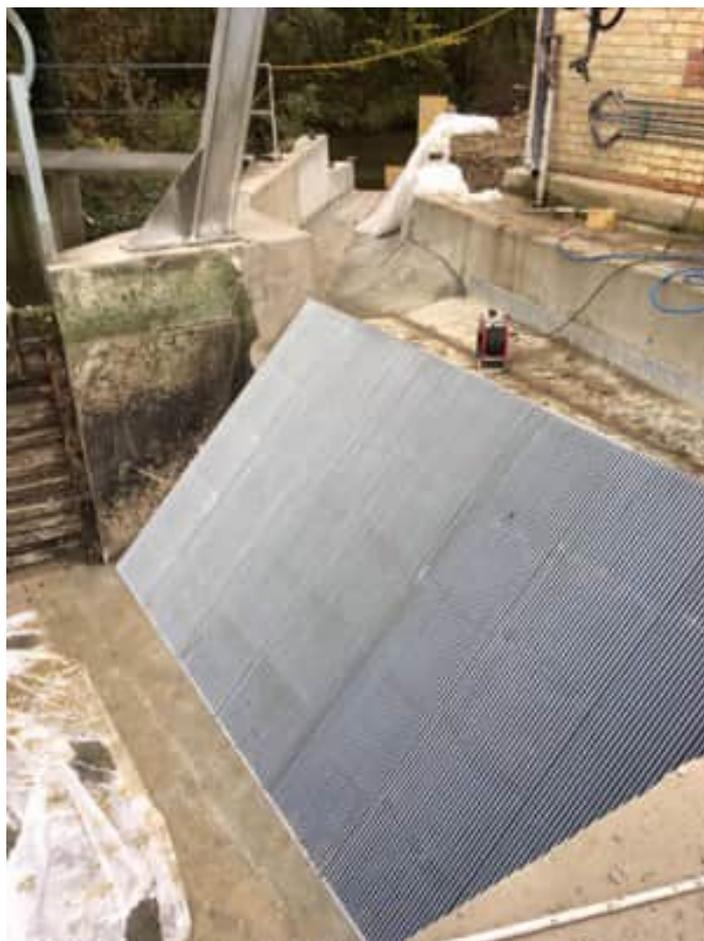
Abbildung 18: Vergleichbarer Feinrechen mit Stababstand 15 mm - Beispielbild der WKA Eyrich an der Schussen
