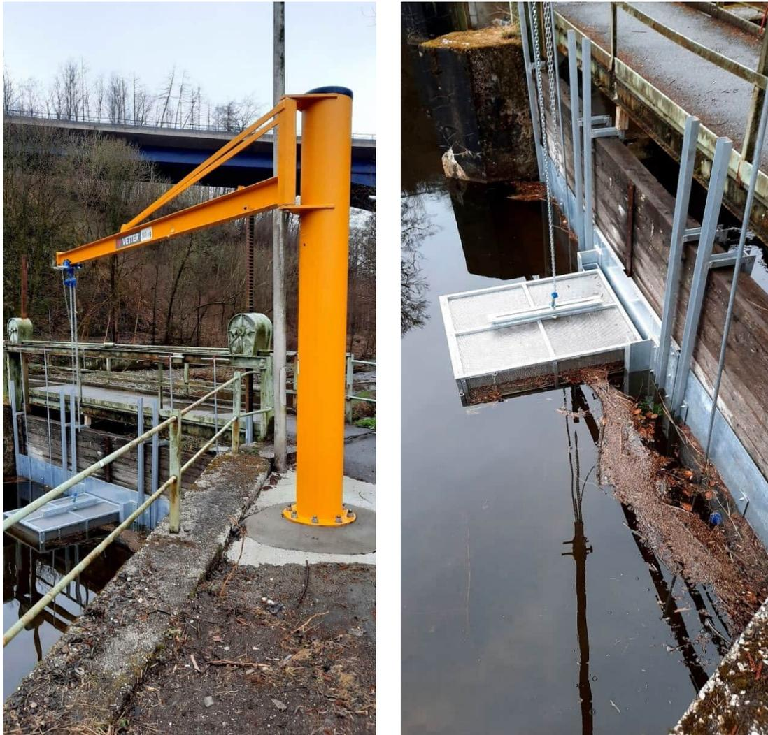
**Abbildung 3: Hebekran und Installationseinrichtung für die Reuse**
