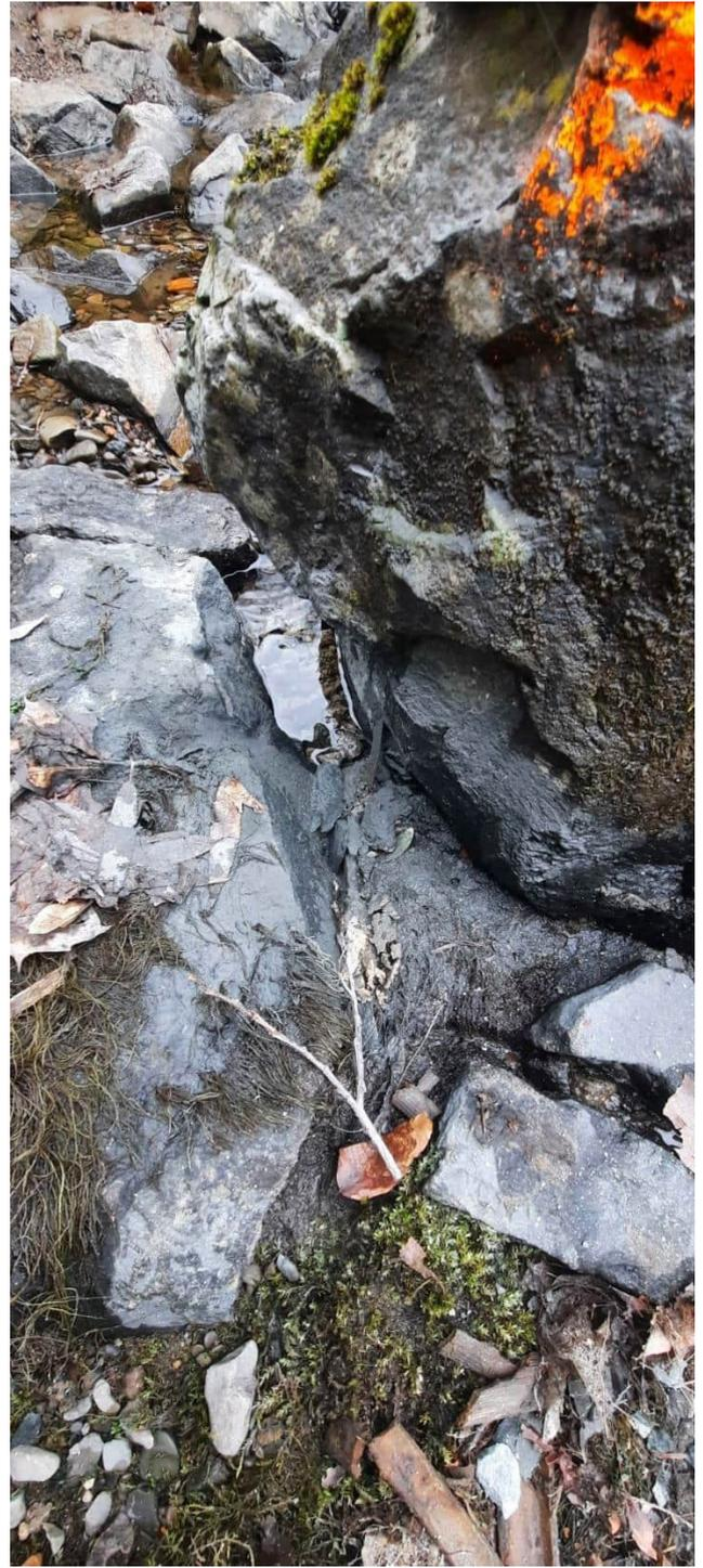
Foto 16: Ausgestemmte Rinne an der Seite eines abgesenkten Blocksteines in einem Durchlass.
