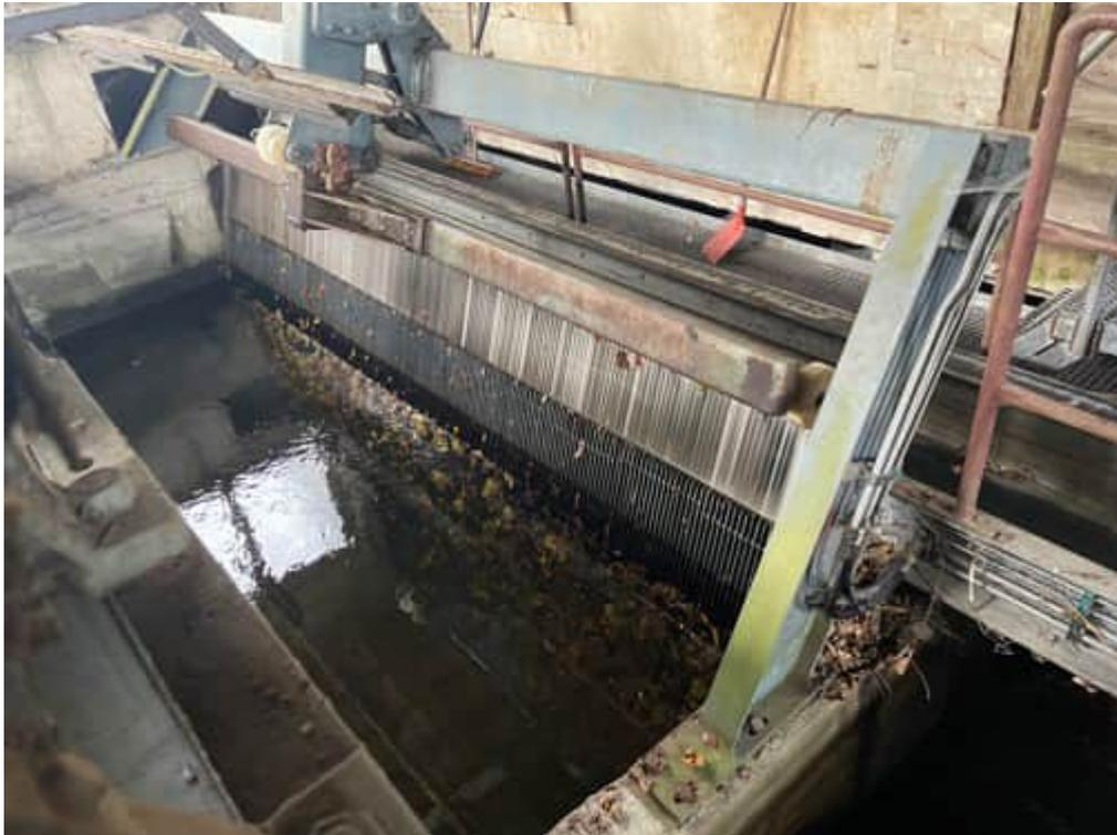
*Abbildung 11: Rechenanlage im Krafthaus der WKA Zoll*
