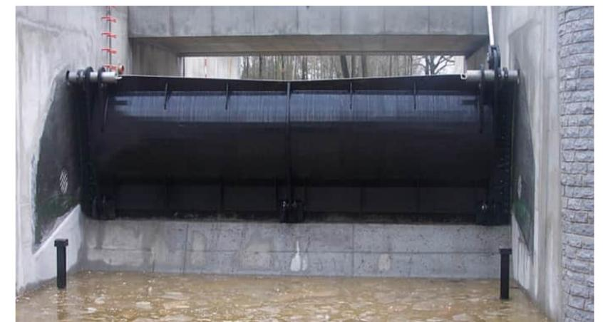
Beispielhafte Wehrklappe mit einseitigem Hydraulikzylinder
