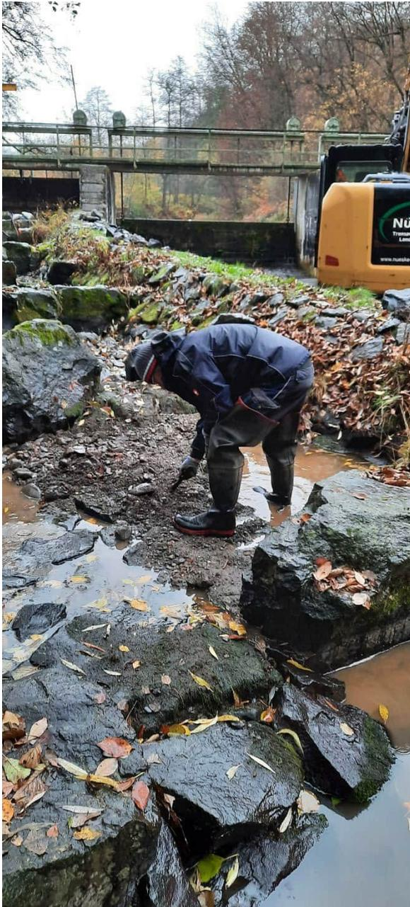
Foto 10: Setzen einer rauen Sohle (Steinrampe) unterhalb eines Durchlasses
