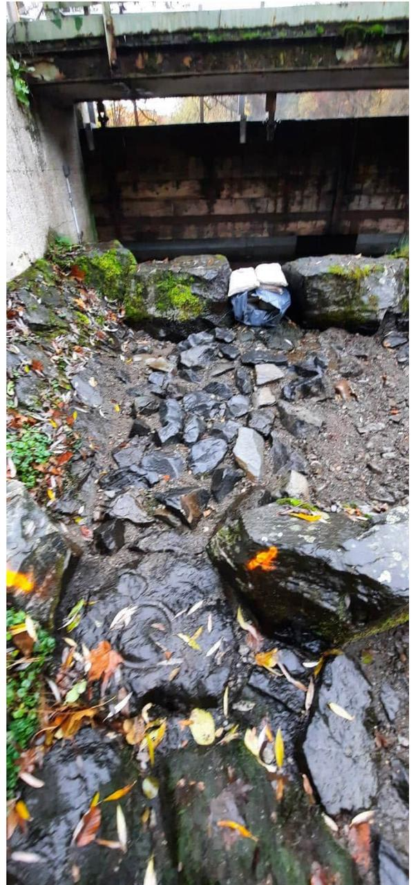
Foto 11: Fertige gesetzte Steinrampe am rechten Durchlass des ersten Querriegels
