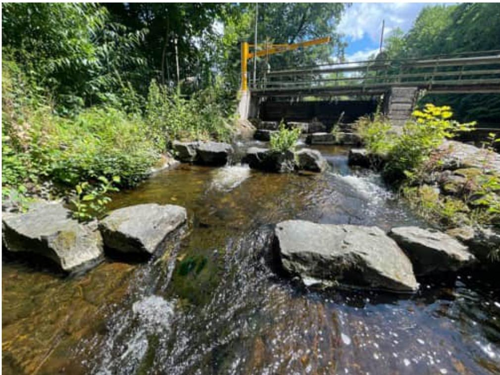
*Abbildung 22: Fischaufstiegsanlage – Abfluss abhängig vom Wasserstand*
