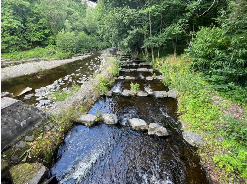
*Abbildung 7: Raugerinne Beckenpass als Fischaufstiegsmöglichkeit an der rechten Uferseite*
