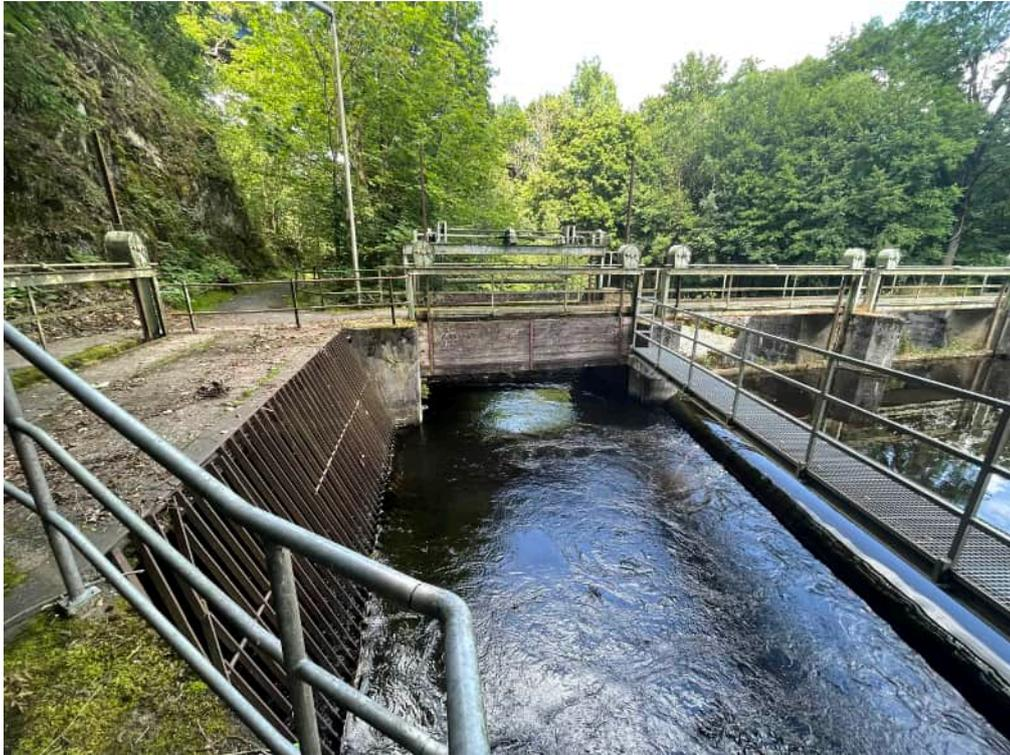
*Abbildung 5: Einlaufbereich mit Einlaufschwelle rechts, Schütztafel mit anschließender Klappe mittig und Einlauf in den Werkgraben links*
