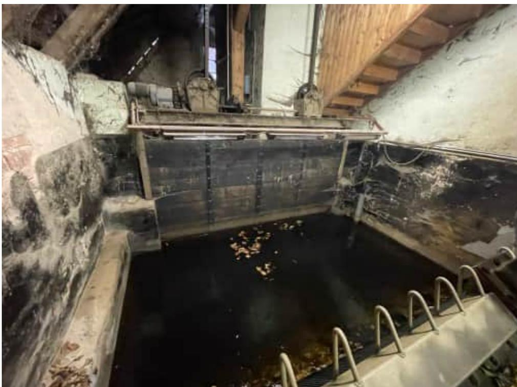
*Abbildung 8: Einlaufschütz der WKA Oderfeld, Rechen im Vordergrund*
