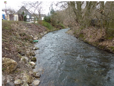
Abb. 2.15: Neile, Blickrichtung abwärts, Frühjahr 2021
